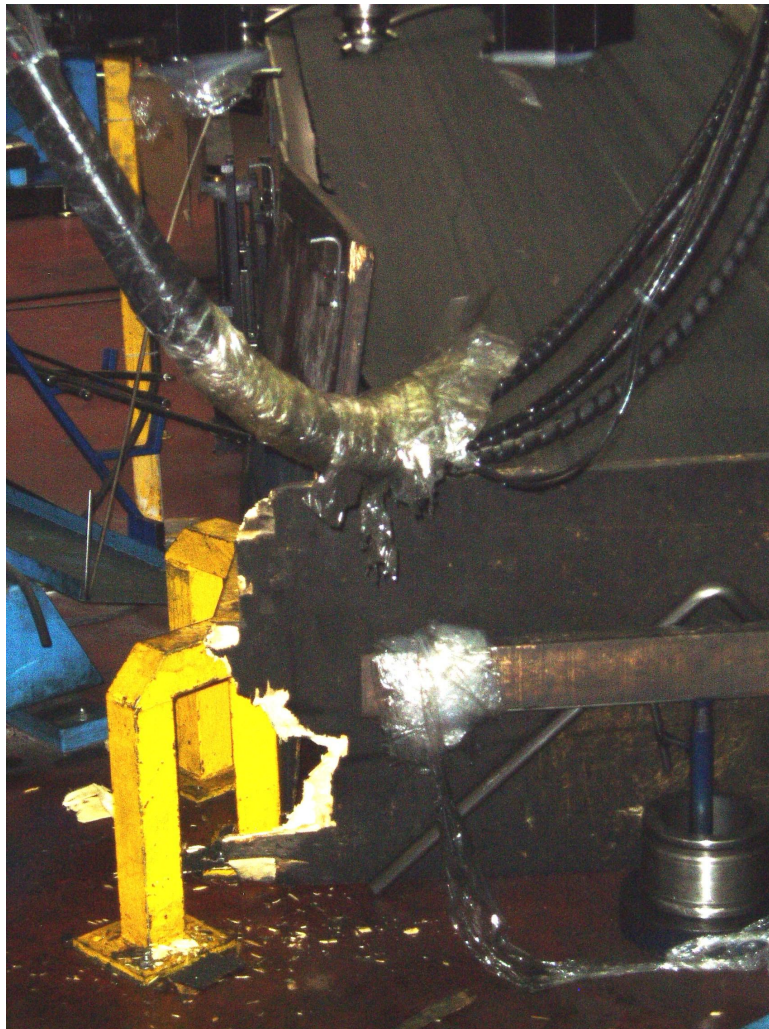
Figura 51 - Particolare delle inappropriate protezioni utilizzate per evitare che i tubi già curvati urtino le strutture metalliche gialle
