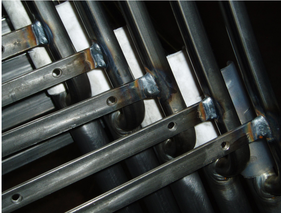
Figura 47 - Particolare del traversino che strofina sul tubo spalliera
