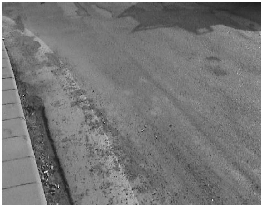
Fig. 2.9 Disgregazione e distacco inerti
