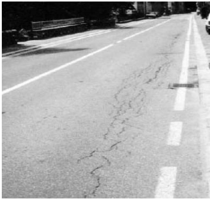
Fig. 3.1 Ondulazioni trasversali e longitudinali
