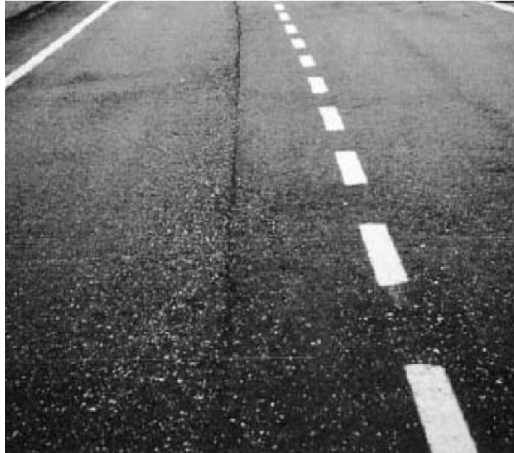
Fig. 2.6 Fessurazioni di giunto
