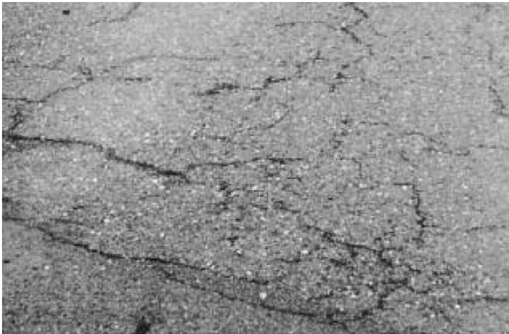
Fig. 2.5 Fessurazione a blocchi
