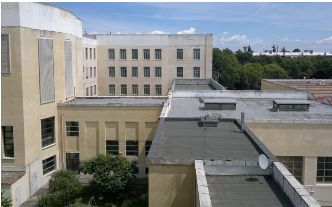
Fig. 3.6b - La copertura piana del reparto officine
