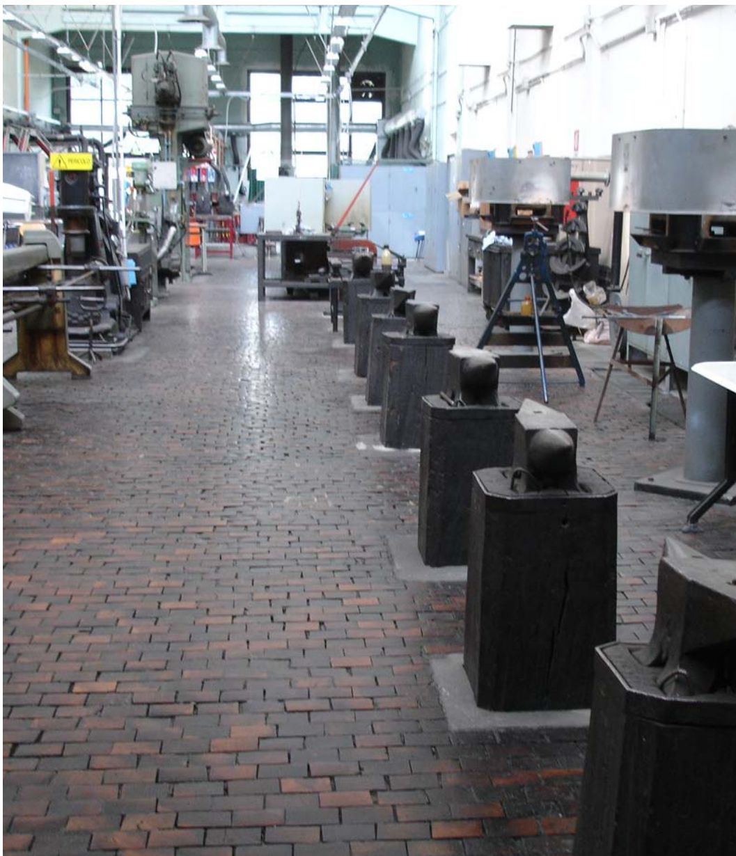
Fig. 3.17 - Foto del pavimento situato nel reparto fucine. (1)
