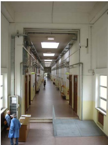
Fig. 3.9a - Panoramica sul corridoio di distribuzione interna del reparto officine
