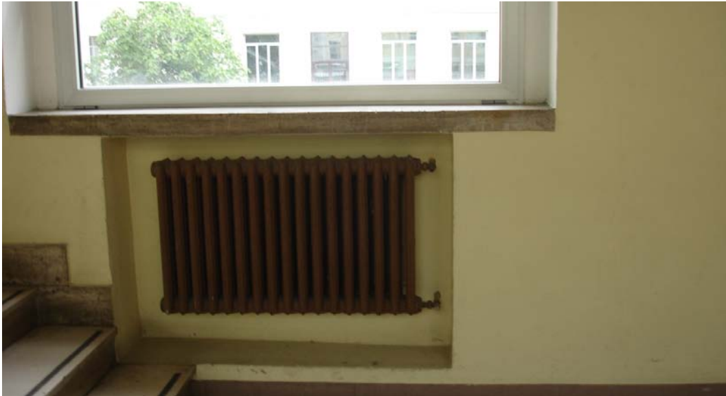
Fig. 4.7a - Particolare di una banchina presente nel corpo di collegamento con le officine
