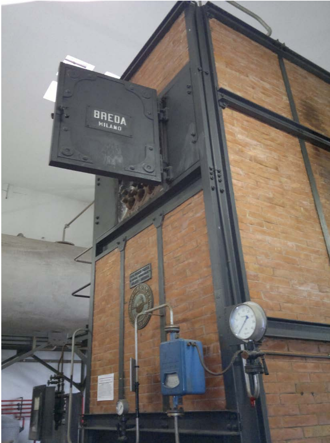
Fig. 3.16 - Foto della centrale termoelettrica presente nell'istituto. (1)
