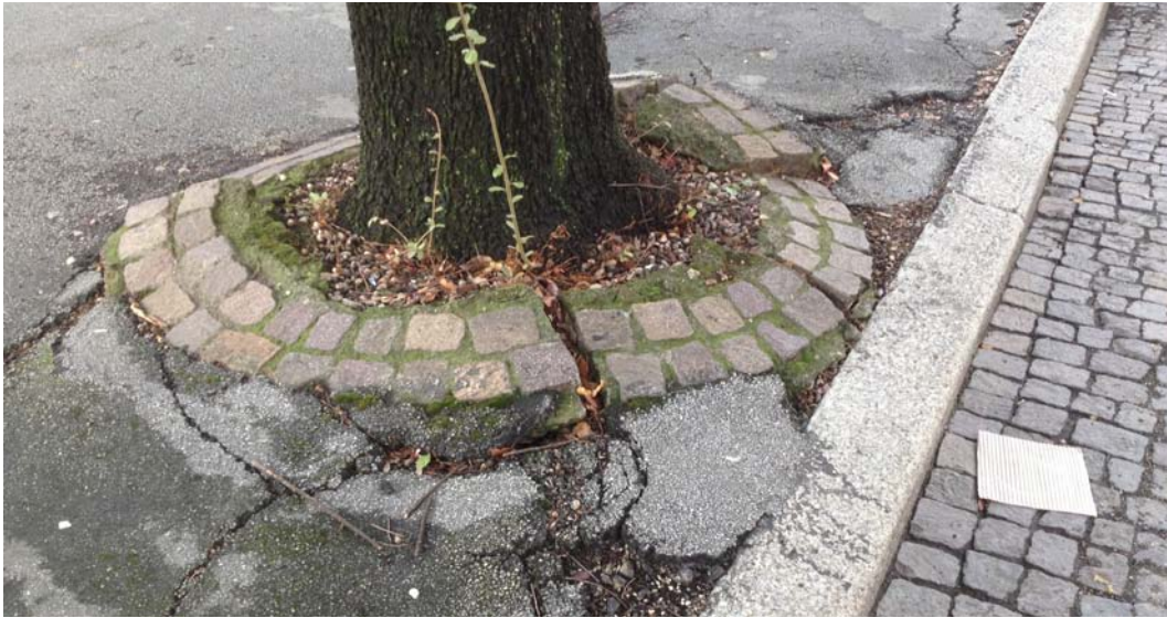
Fig. 4.3 - Lo stato di degrado del manto stradale dei marciapiedi centrali
