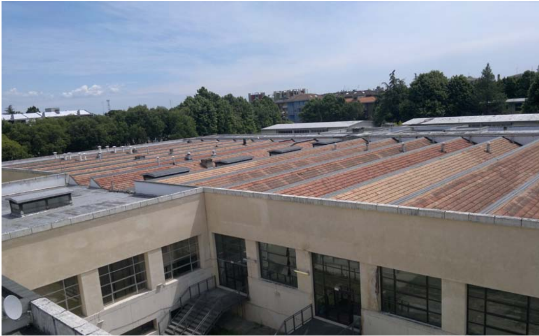
Fig. 3.6a - La copertura "a shed" del reparto officine
