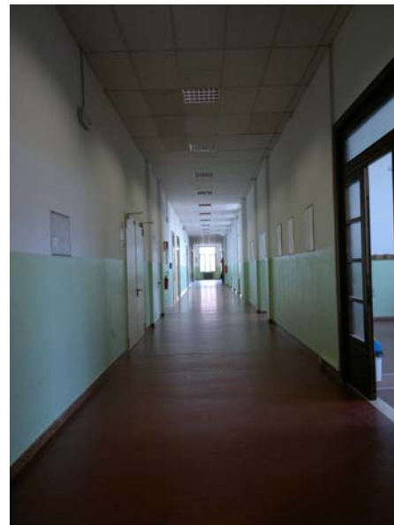
Fig. 3.4b - Vista su corridoio al piano primo
