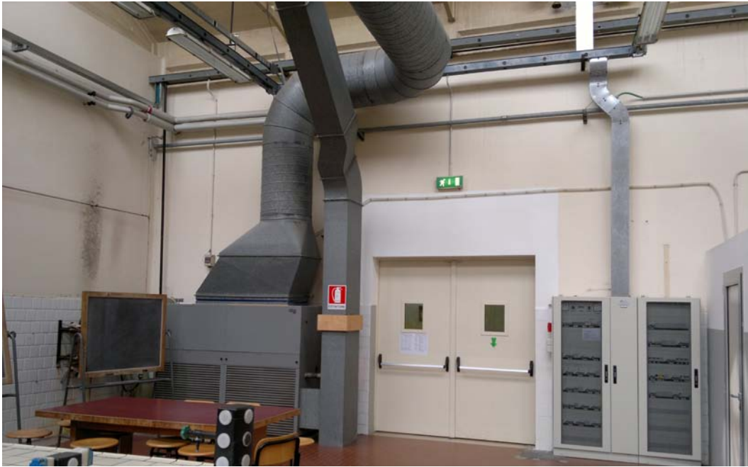
Fig. 3.8 - La piccola unità trattamento aria presente in ogni officina
