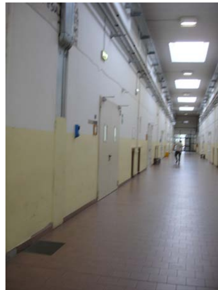
Fig. 3.9b - Corridoio interno con in evidenza una recente porta REI
