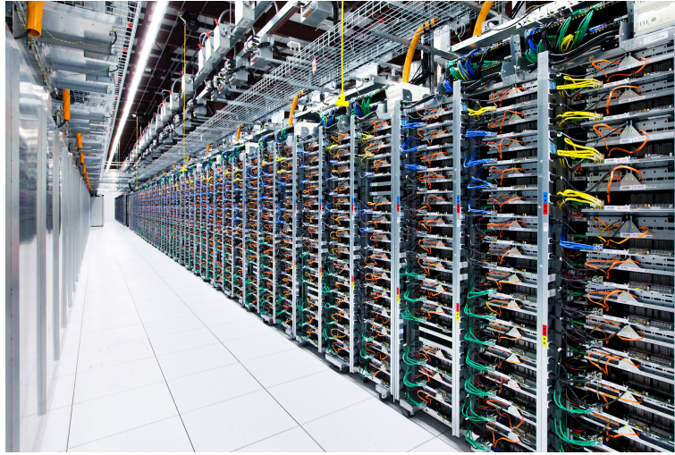
Figura 1.1: Data center di Google
