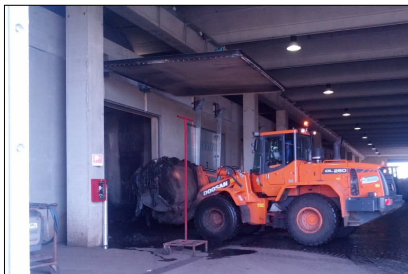
Figura 1.16 - Operazione di "caricamento" dei digestori
