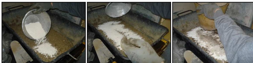
Figure 4.11, 4.12 e 4.13 - Stesa calce e aggiunta acqua di miscelazione.
