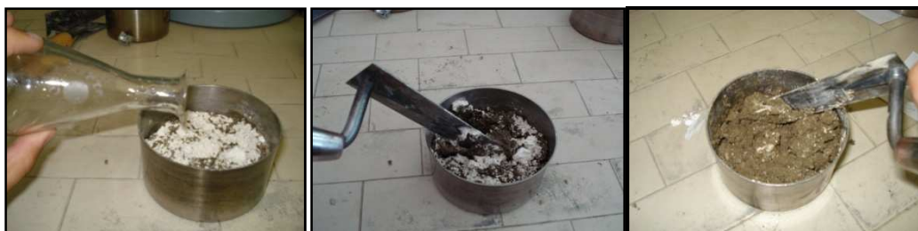
Figure 4.47, 4.48 e 4.49 - Miscelazione calce.
