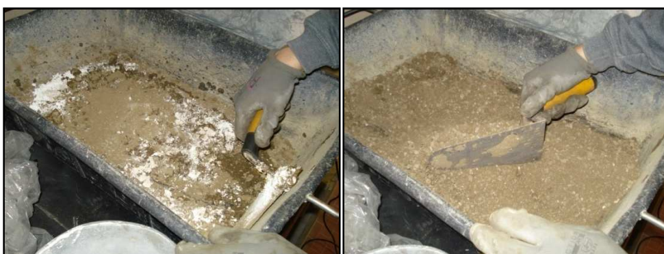
Figure 4.14 e 4.15 - Miscelazione calce.
