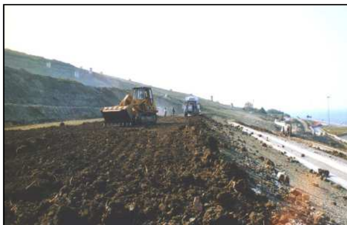
Figura 1.14 – Preparazione del terreno al trattamento attraverso lo scotico.
