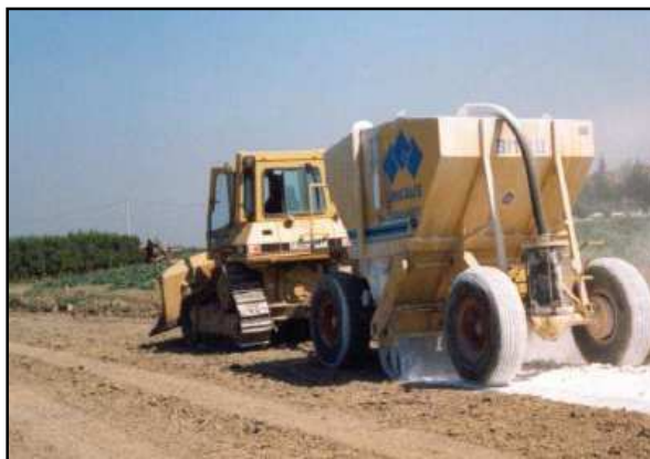
Figura 1.15 – Macchinario spandi calce per lo spargimento della calce sfusa.
