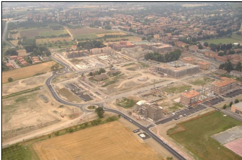
Figura 2.14 –Particolare dall’alto della località di cantiere.
