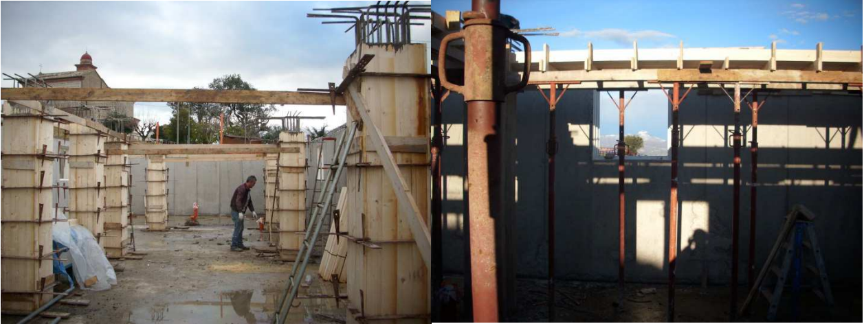
Posizionamento dei travetti e delle pignatte appoggiati su cassaforme
