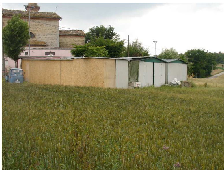
Foto n. 2 ( prospetto Sud-est e Nord-est )
