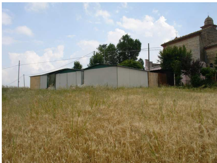
Foto n. 1 ( prospetto Nord-est e Nord-ovest )
