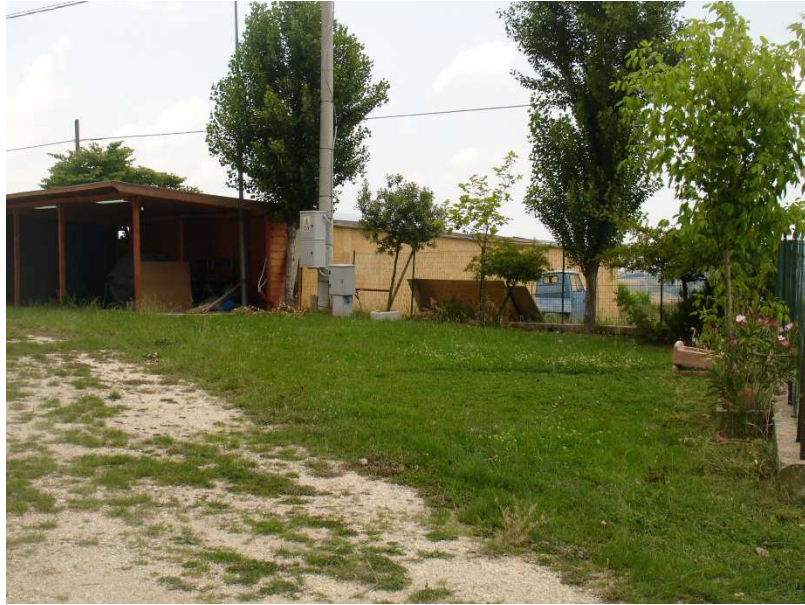
Foto n. 3 ( prospetto Sud-est e cortile Chiesa della Bura )
