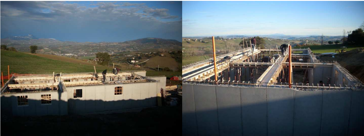
Posizionamento dei ferri di travi (prima i travi di spina poi i cordoli)
