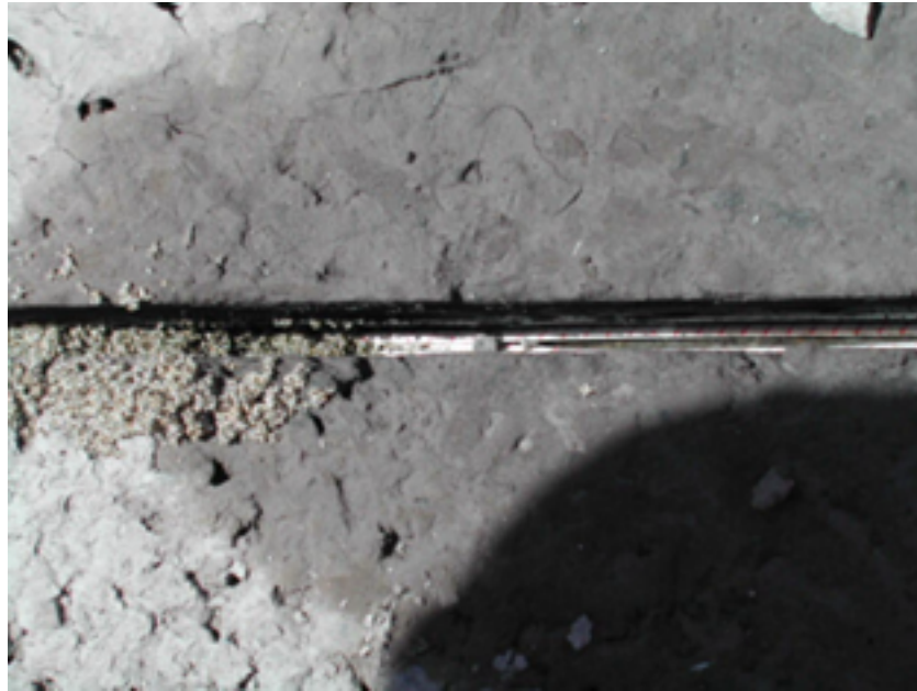
Figura 2.7: Foto dell'inserimento del cavo nel cemento
