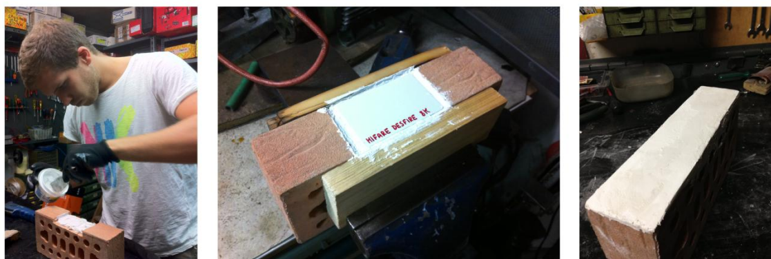
Figura 5.2: da sinistra verso destra le fasi della realizzazione dello Smart Brick: a sinistra il riempimento dello scasso, al centro il posizionamento del Tag, infine a destra la ricopertura finale.
