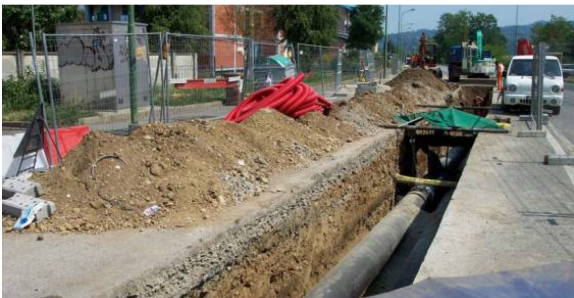
Fig. 1.5 – Scavo in trincea per la posa di una tubatura in ambito urbano
