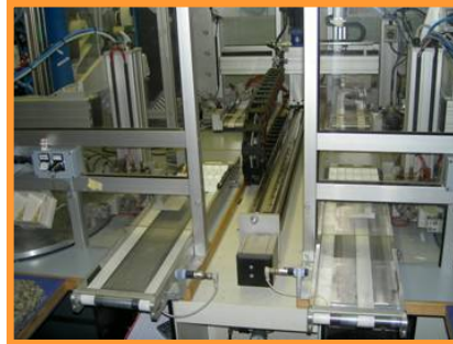
Postazione di lavoro – Visuale interna
