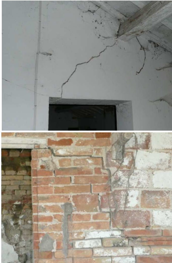
Figure 15 e 16 - Alcune lesioni presenti causate da cedimenti differenziali della fondazione.
