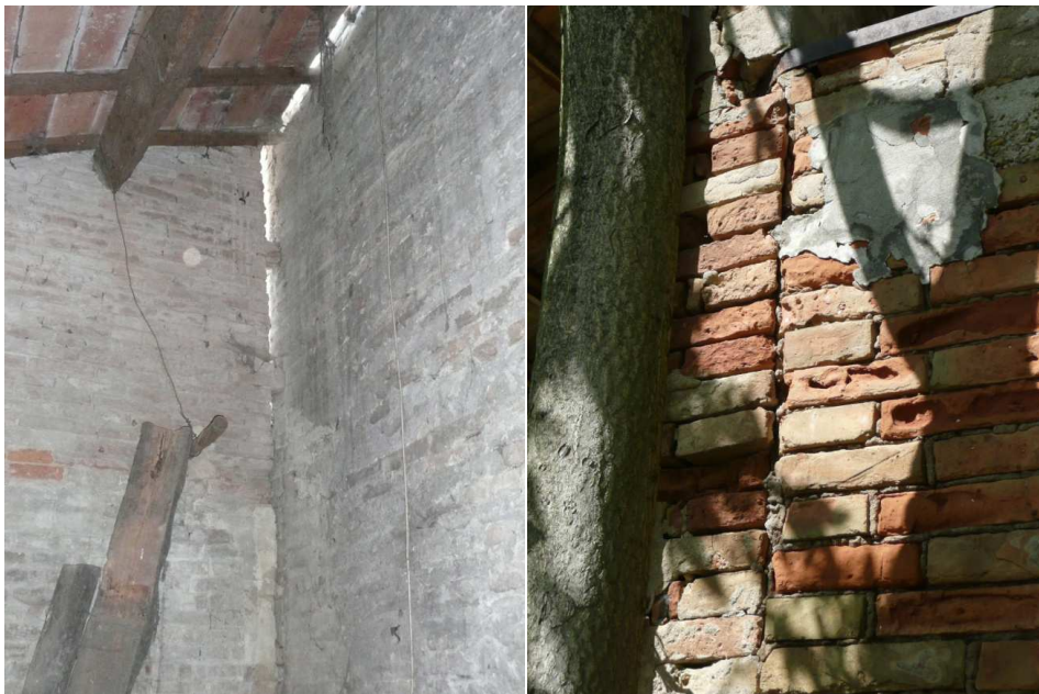
Figura 14 - Tipiche lesioni dovute alla mancanza di ammorsamenti.
