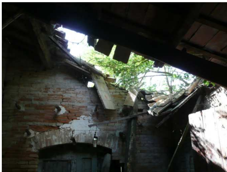
Figure 17 e 18 - Crolli di un muro portante in terra cruda e della copertura della cantina.
