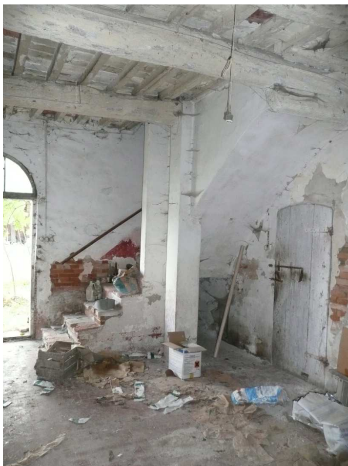
Figura 11 - Particolare della scala attuale
