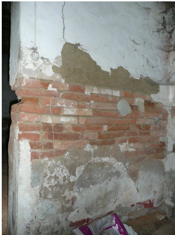
Figura 19 - I muri dell'edificio sono in terra cruda da una quota di 120cm dal piano di calpestio.
