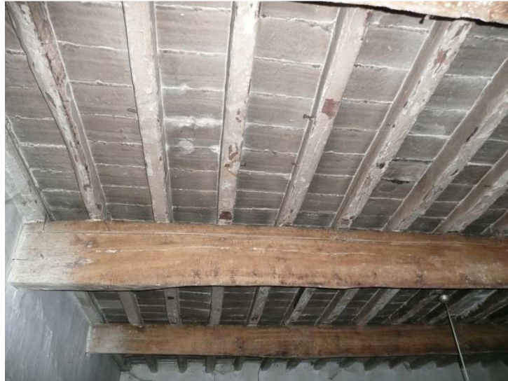
Figura 12 - Solaio di piano dell'attuale cucina
