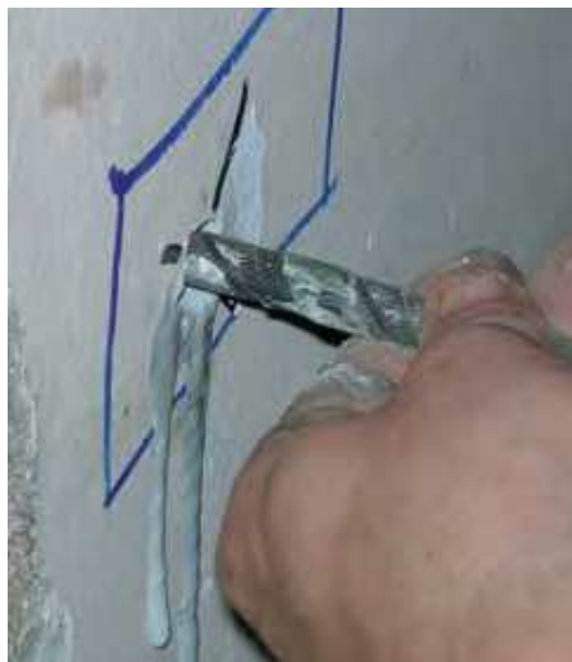
Figura 29 - Inserimento di una barra in fibra di carbonio all'interno di un foro.
