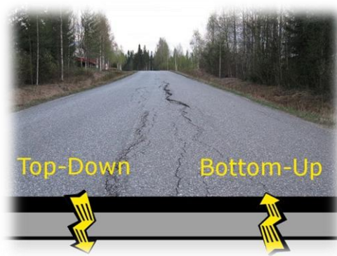
Figura 5. 67: Propagazione delle fessure nelle pavimentazioni stradali
