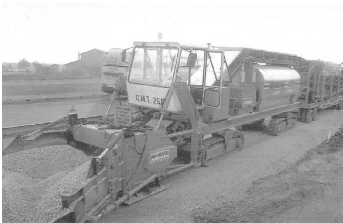
Figura 3. 25: Foto di un treno di riciclaggio CMT 250 della MARINI (Pavimental Autostrade spa)
