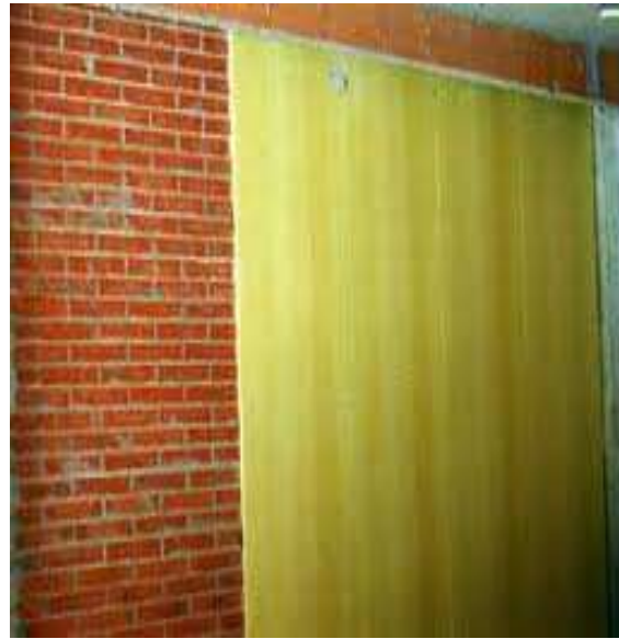
Fig. 8: applicazione della controparete in legno.
