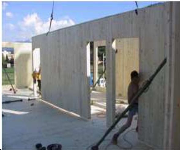
Fig. 21: posa in opera della parete portante.
