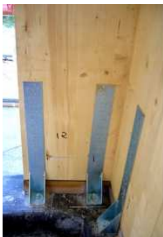
Realizzazione del collegamento fondazione-parete
