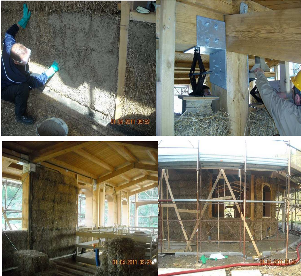
Fig. 53: realizzazione di una casa in balle di paglia. (Fonte: EcoBioEdilizia)
