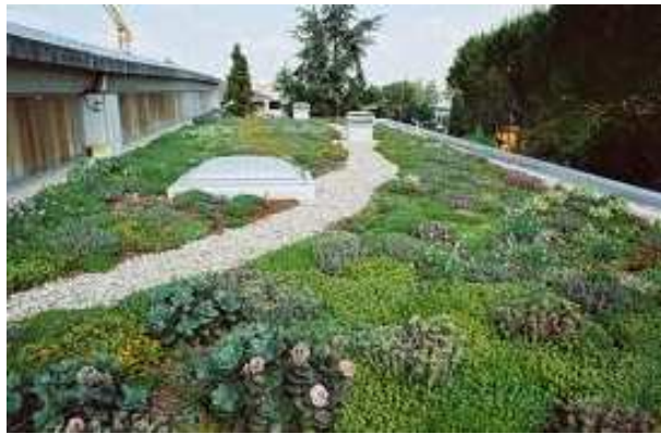
Fig. 28: Tetto a giardino.
