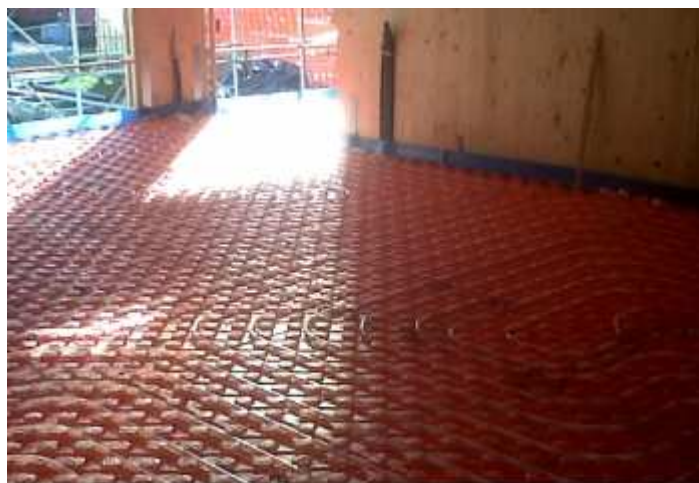
Posa del riscaldamento a pavimento
