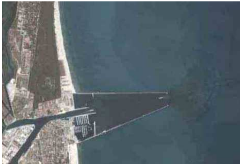
Figura 19 Estensione delle dighe foranee del Porto Canale di Ravenna.
