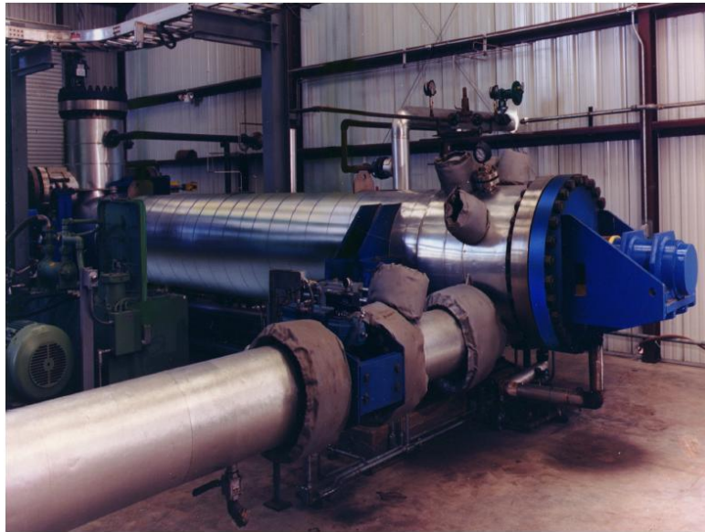
Figura 1.14: Impianto di Steam Explosion
