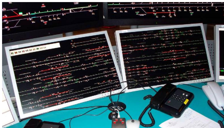
Fig. n. 2.70 Monitor per visione ed intervento sulla linea
