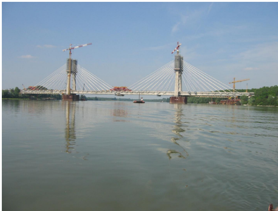
Fig.n. 1.32 Il ponte sul fiume Po terminato a settembre 2006
