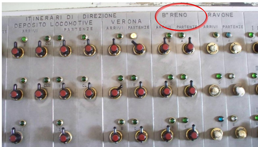
Fig. n.4.105 Particolare del Banco di Manovra della Cabina A
