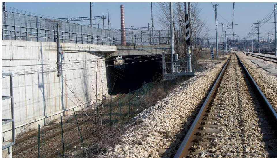
Fig. n. 5.130 Il sottovia Buca
