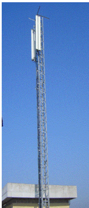
Fig. n. 1.5 Fotografia delle antenne BTS (Base Transceiver Station)
