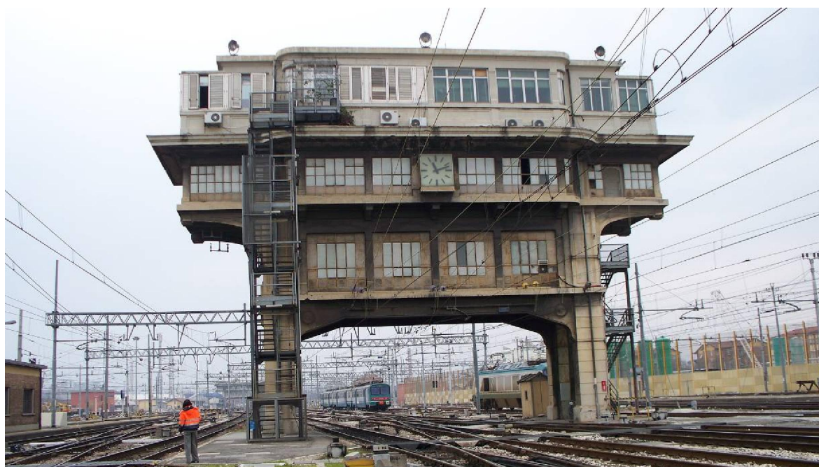
Fig. n. 4.100 La Cabina A di Bologna C.le dove ha sede l'A.C.E.L.I.
