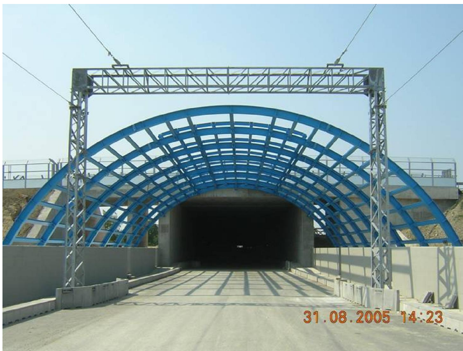
Fig. n. 1.29 Galleria artificiale di Fontanellato
