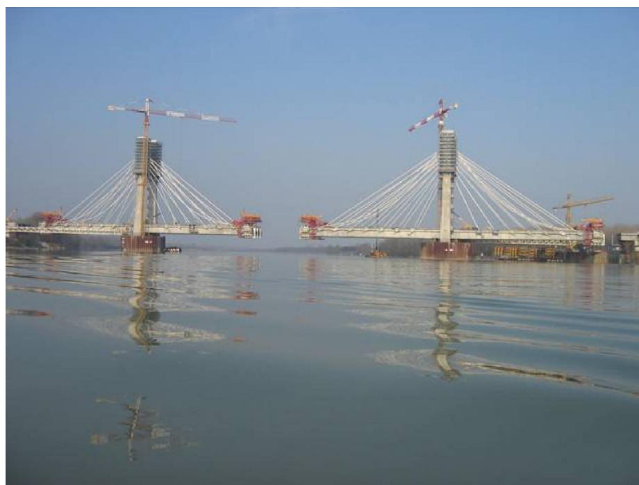
Fig. n. 1.30 Costruzione del ponte sul fiume Po
