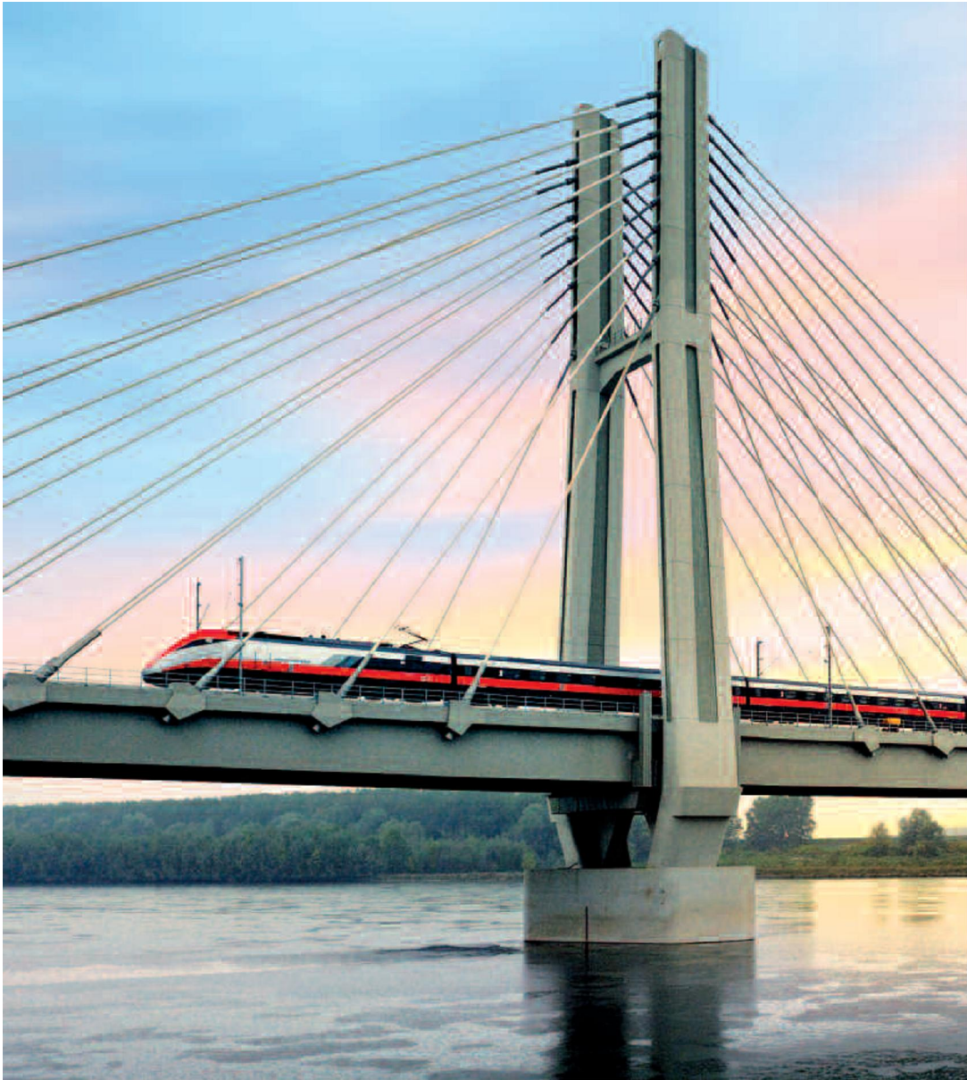
Fig. n. 7.170 Il Frecciarossa sul nuovo ponte sul Po
