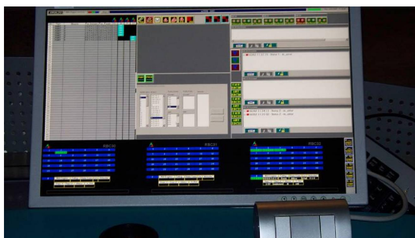
Fig. n. 2.73 Monitor del Radio Blocco
