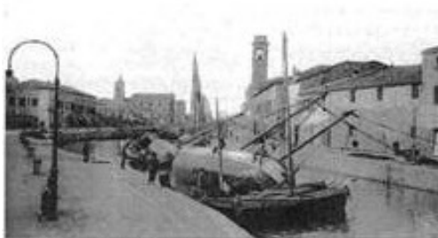
Fotografia della camera delle barche sul porto canale agli inizi del Novecento.
