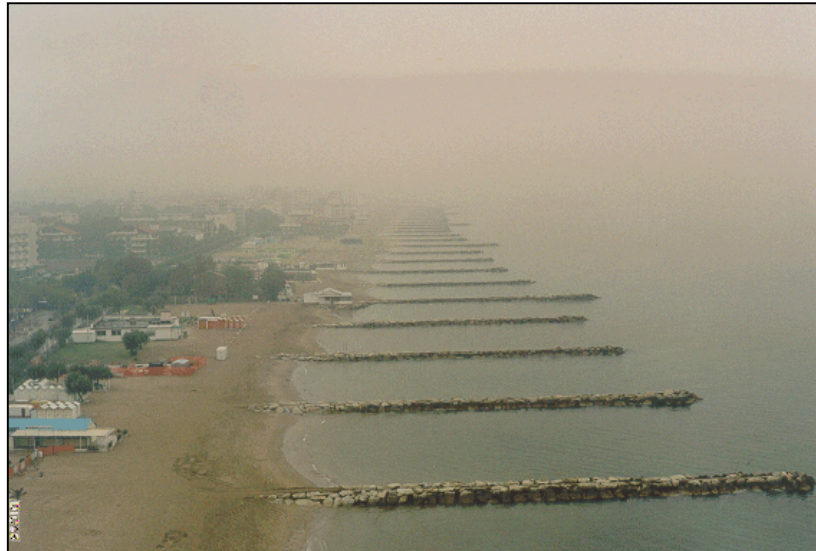
Figura 31 - Spiaggia di Misano (RN): si noti la conformazione a denti di sega che ha assunto la spiaggia a seguito della costruzione dei pennelli.
