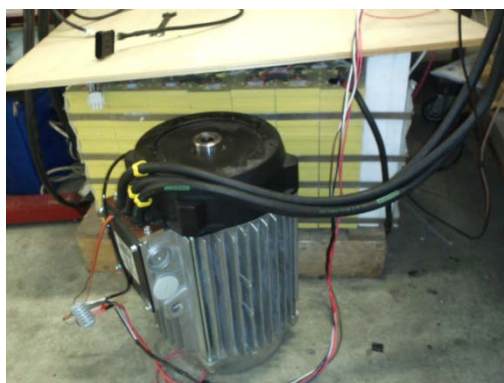
Fig. 5 - Motore elettrico (in primo piano) e batterie (in secondo piano)
