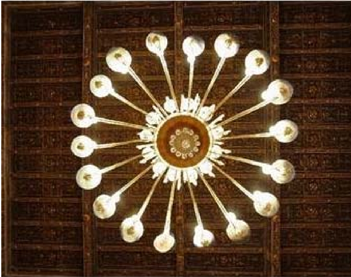
Figura 5: Copertura lignea con solaio a cassettoni del salone d'onore
