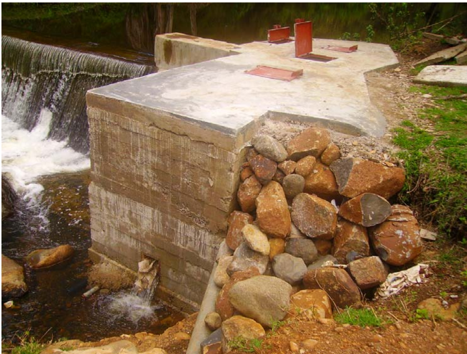
fig.2.6_Dettaglio della traversa e dell'opera di presa (fonte: [7])
