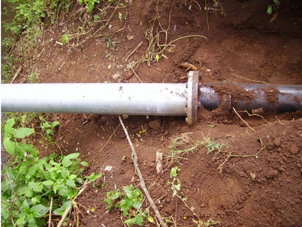
fig.2.7_Cambio di materiale e interro delle tubazioni (fonte: [7])
