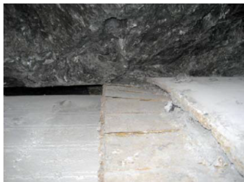
Figura 8: Blocco di una TBM a scudo singolo in ammasso spingente durante le operazioni per liberarla (Uluabat Tunnel, Turchia)([16]).
