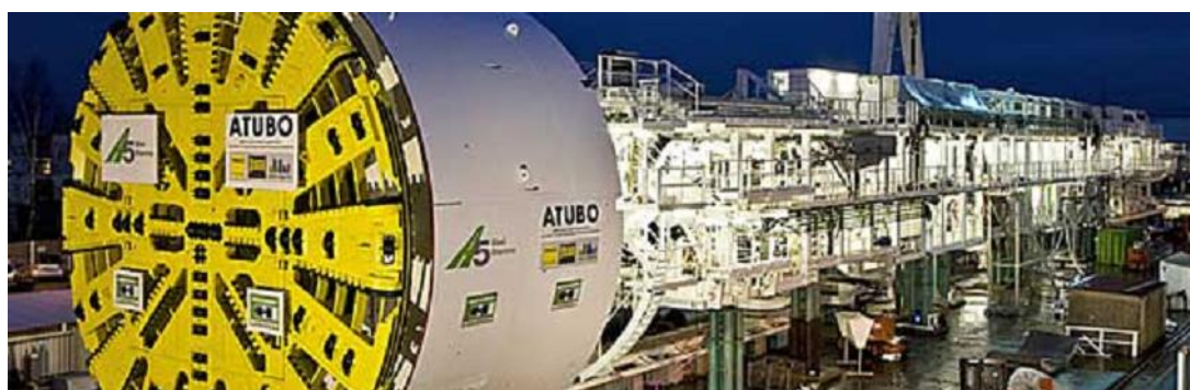
Figura 3.12 TBM Herrenknecht EPB S-452 impiegata per la realizzazione dei tunnel della Biel East [49]
