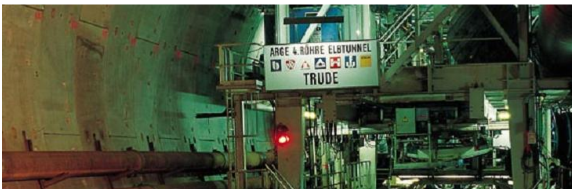
Figura 3.10 TBM Herrenknecht S-108 impiegata per la realizzazione del Röhre Elbtunnel Hamburg [49]
