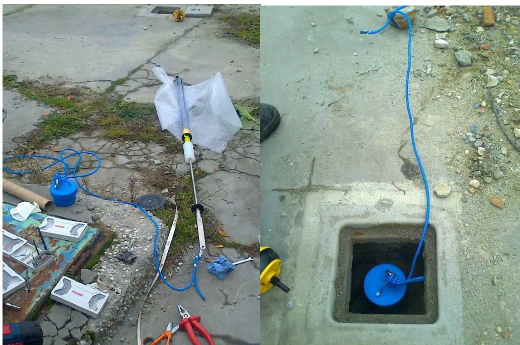
Figura 5.52 Montaggio e posa dello skimmer passivo nel P7 il 19/01/2012, a destra una vista dall'alto dello skimmer appena calato nel piezometro
