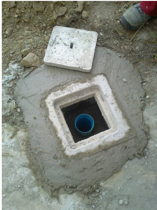
Figura 4.11 Testa del piezometro con relativo pozzetto di protezione
