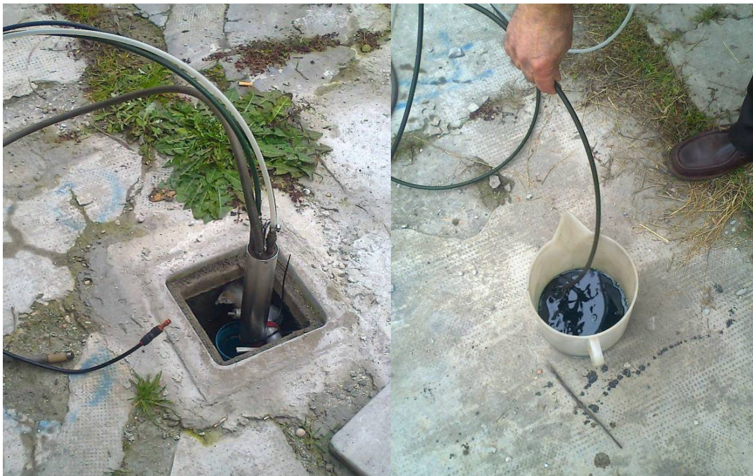
Figura 5.51 Posa dello skimmer attivo nel P14 del 19/01/2012, a destra è in corso la rimozione del solo PL
