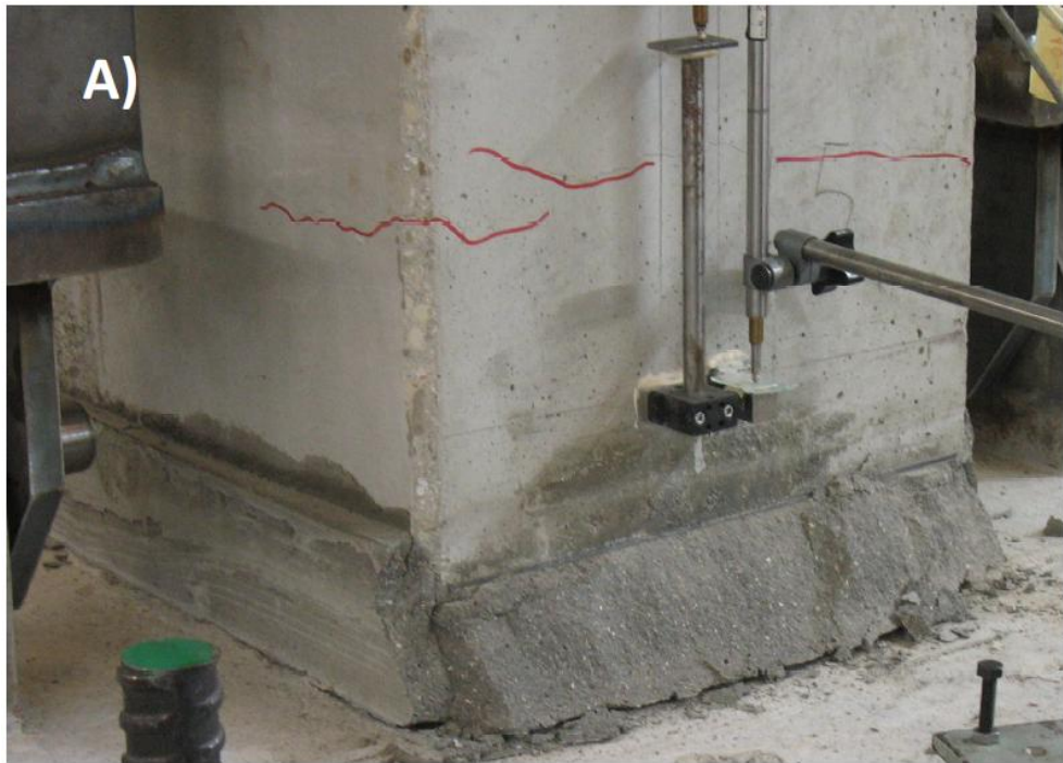
Figura 20 - Distacco del colletto di emaco - particolare lato fronte contrasto
