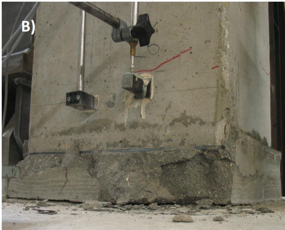
Figura 21 - Distacco del colletto di emaco - Particolare lato opposto
