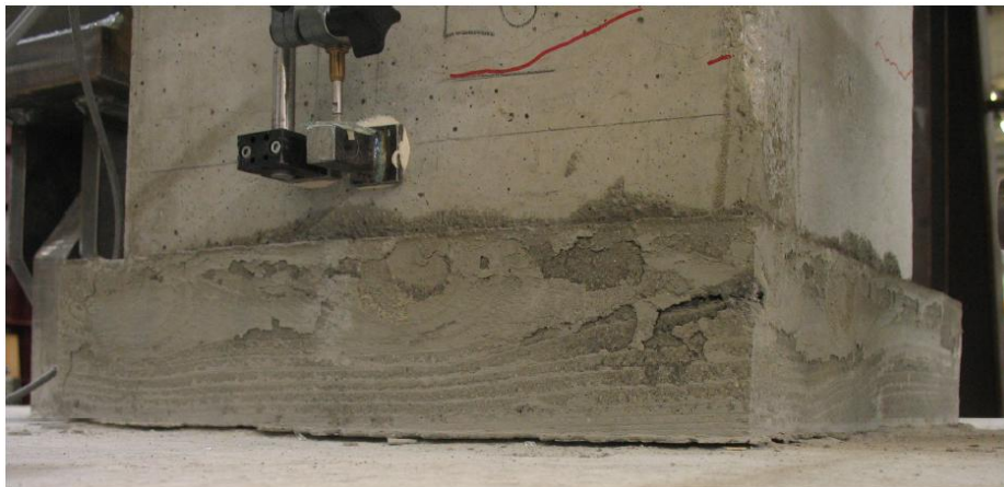
Figura 17 - Fessurazione del colletto di base di emaco
