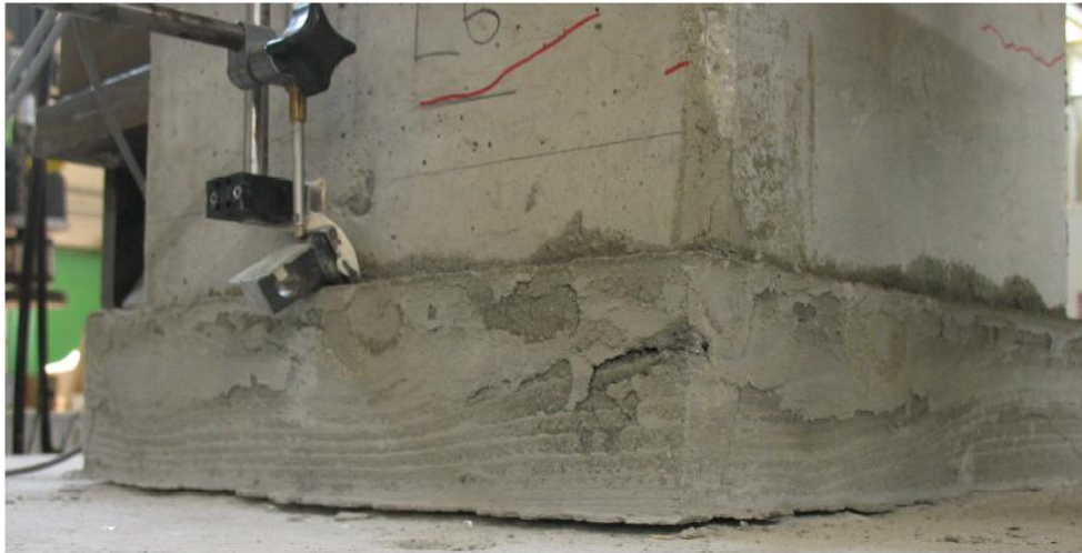
Figura 18 - Distacco di uno degli strumenti per la misurazione della rotazione alla base in corrispondenza del primo ciclo a 40 mm
