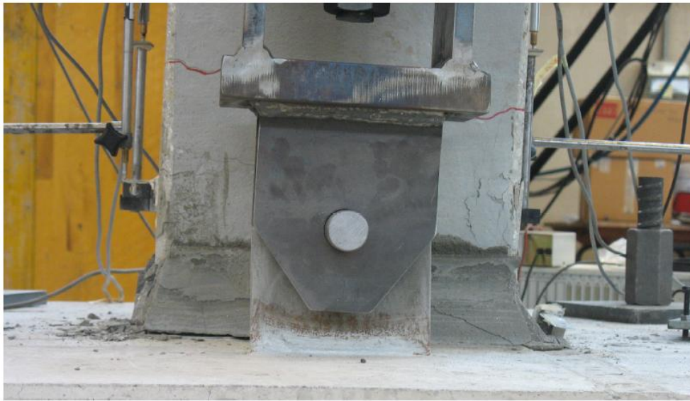
Figura 22- Particolare della rotazione alla base del pilastro
