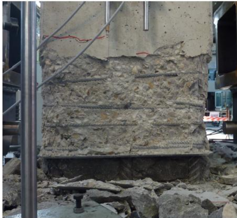
Figura 28 - Danneggiamenti finali alla base del pilastro
