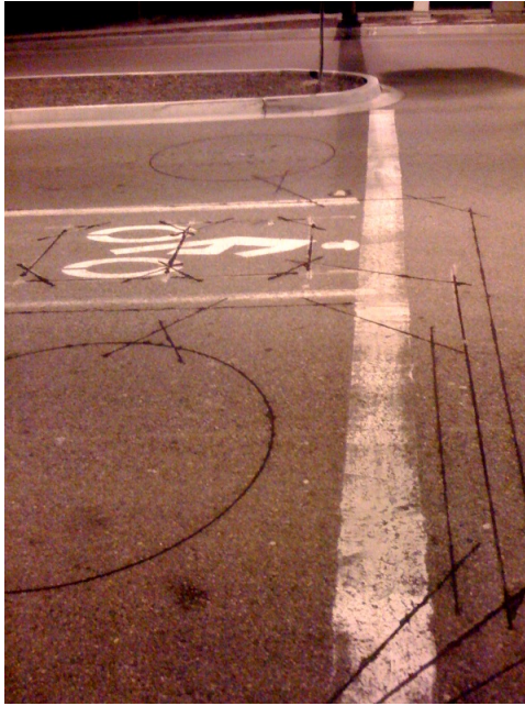
Figura B.1: Manto stradale dove è possibile vedere dove sono state posizionate le spire [21].
