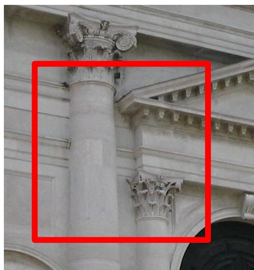
Figura 43 Trabeazione che gira come nella Basilica del Redentore. A destra: dettaglio della trabeazione del Redentore.
