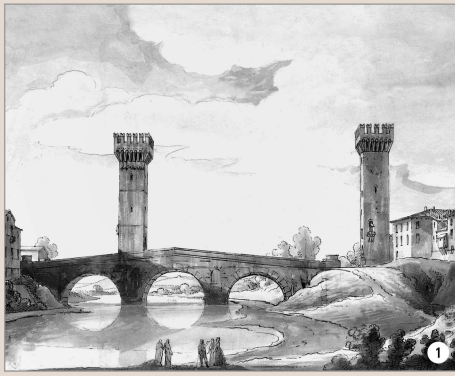
Ponte delle Torri visto da valle
