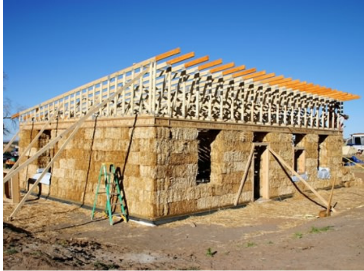
Figura 6: Costruzione di una casa "Nebraska style", con parete di paglia portante
