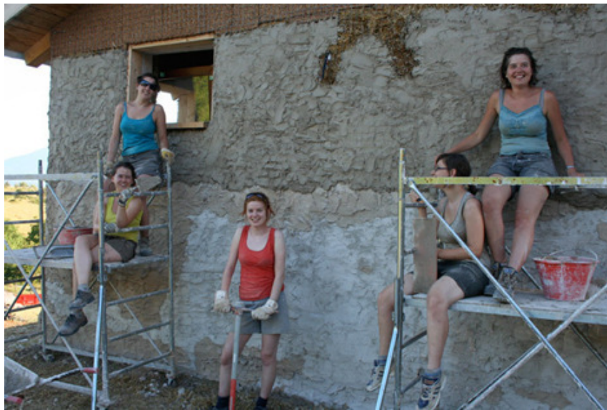
Figura 62: Stesura dell'intonaco esterno, in alto è visibile lo strato di sughero
