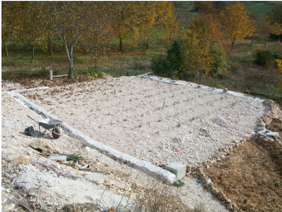
Figura 43: Realizzazione dell'impianto di fitodepurazione
