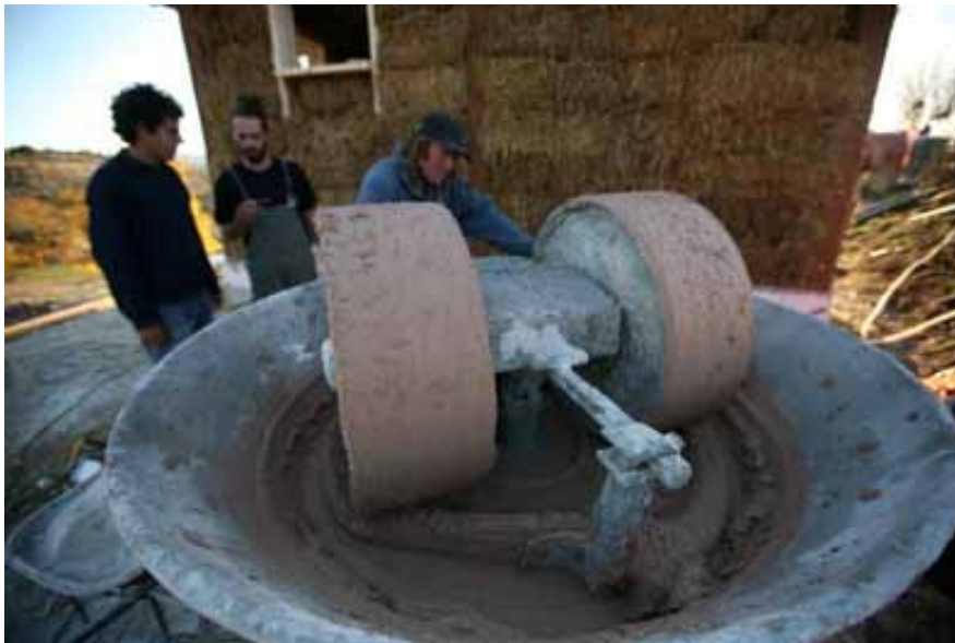
Figura 48: Impastatrice in funzione durante i lavori
