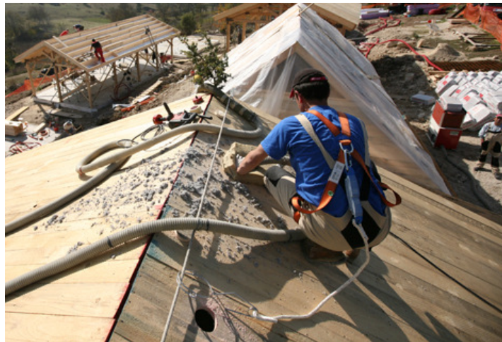
Figura 59: Insufflaggio della fibra di cellulosa tra i 2 tavolati
