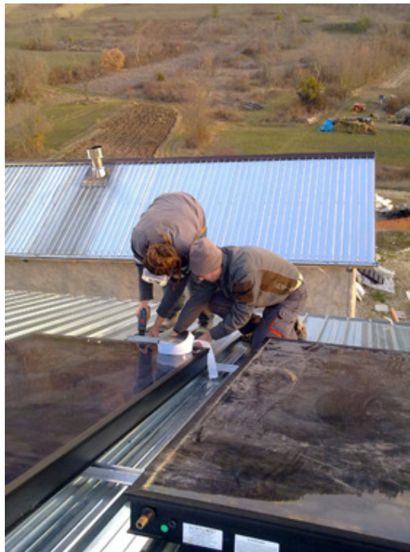
Figura 64: Installazione dell'impianto solare termico
