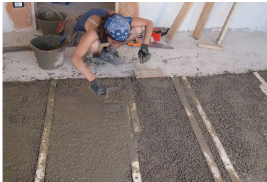
Figura 54: Pavimentazione in pomice
