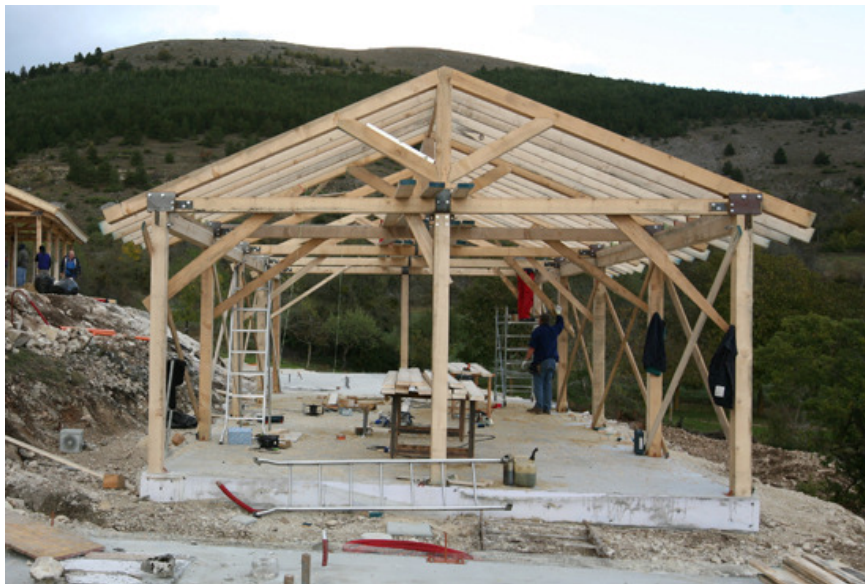
Figura 51: La struttura portante completata
