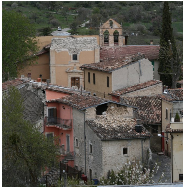
Figura 33: vista del paese distrutto dal terremoto
