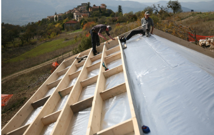
Figura 58: Costruzione dei "cassetti" del tetto, da riempire con la fibra di cellulosa
