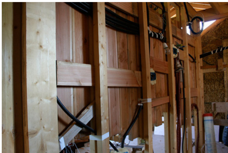
Figura 63: I muri divisorii in legno, contenenti i tubi degli impianti
