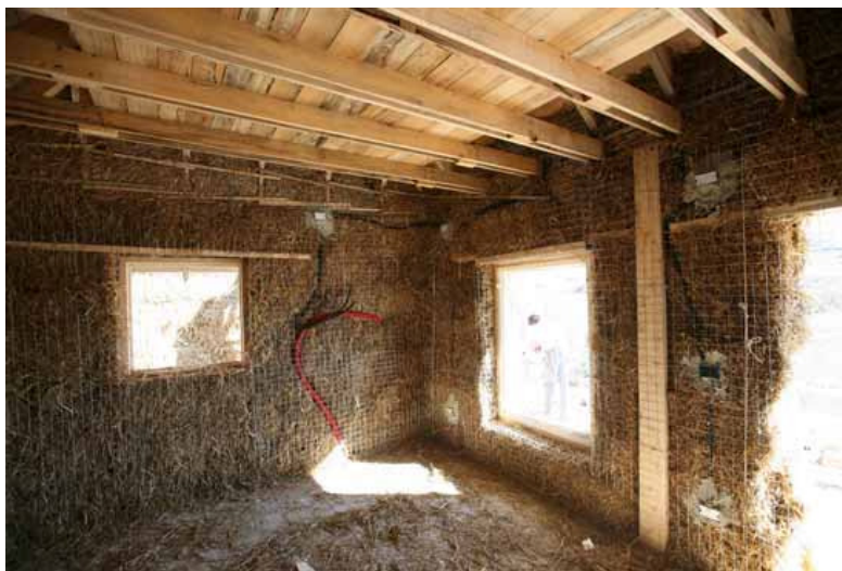
Figura 53: Tamponatura completata e rete zincata
