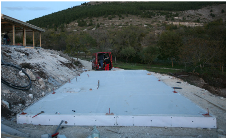
Figura 49: Vista della platea in calcestruzzo armato
