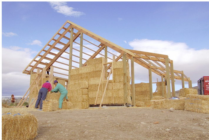
Figura 7: Costruzione di una casa "post and beam" che struttura portante in legno
