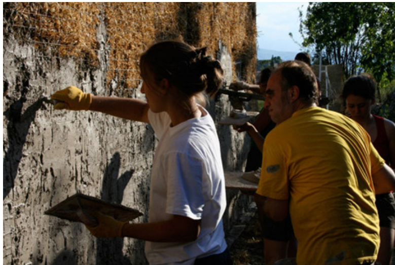
Figura 61: Stesura dell'intonaco esterno
