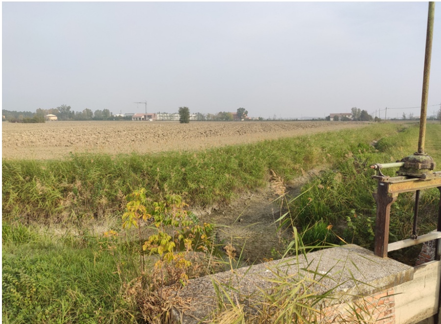
Figura 2.10: Vista dell'inizio del canale Quarantoli in corrispondenza dell'incontro del dugale Cucco (da sinistra) con il dugale Acquaviva (da destra).
