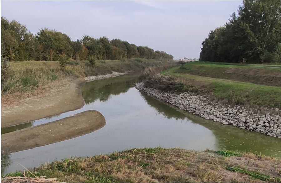
Figura 2.3: Vista dell’inizio del canale Collettore di Burana in corrispondenza dell’incontro del canale Quarantoli (da sinistra) con la fossa Mozza (da destra). In lontananza si intravede il ponte dei Santi, manufatto rilevato nel corso della campagna topografica.
