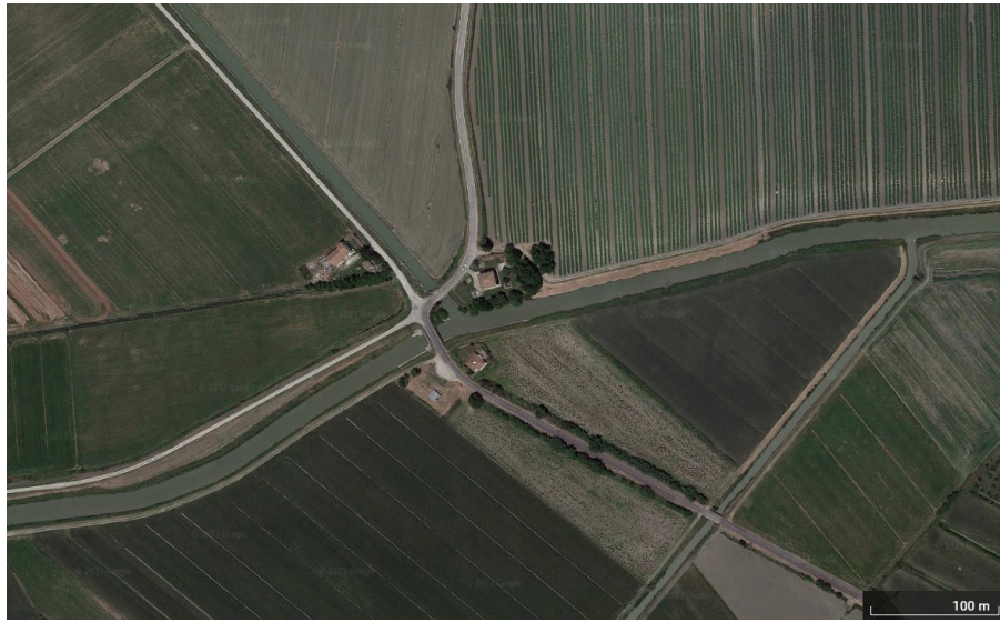
Figura 2.26: Fotografia aerea del nodo idraulico di Passo dei Rossi. Si vede chiaramente gli alvei del canale Quarantoli (da ovest verso est), del dugale Piva ramo Segonda (da nord-ovest) e della fossa Scaletta (da nord-est). Il tracciato stradale transita sul sostegno Passo dei Rossi e sulla chiavica del dugale Piva ramo Segonda.
