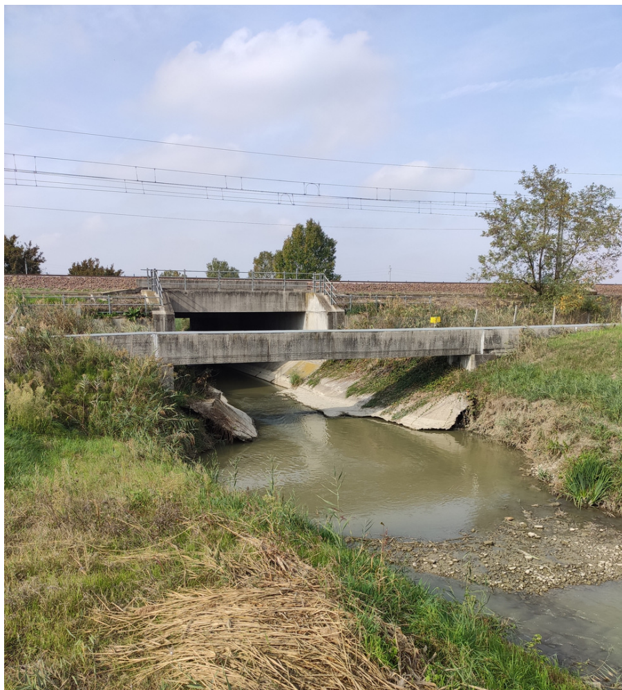
Figura 3.3: Vista di valle del ponte ferroviario sul canale Quarantoli. Di fronte al manufatto si vede il grigliato per l'attraversamento pedonale dal quale è stato effettuata la misura.
