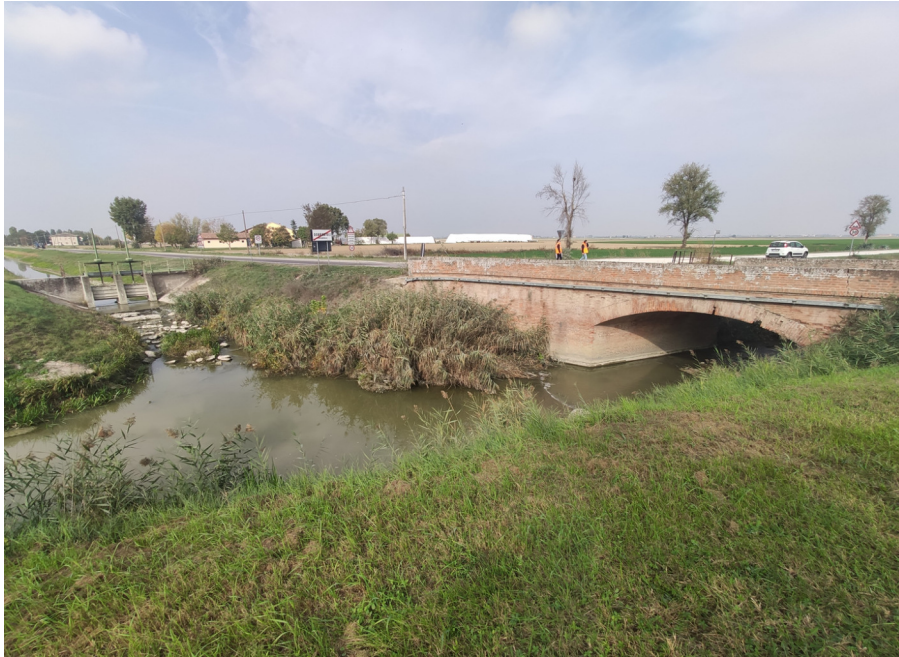
Figura 2.14: Vista dello sbarramento che governa l'immissione del dugale Zalotta nel canale Quarantoli, immediatamente a monte di ponte Argine Nuovo.
