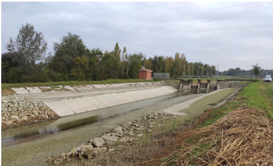
Figura 2.29: Vista del sostegno Sbrocco del Quarantoli da monte, fotografia del 2/11/2022.
