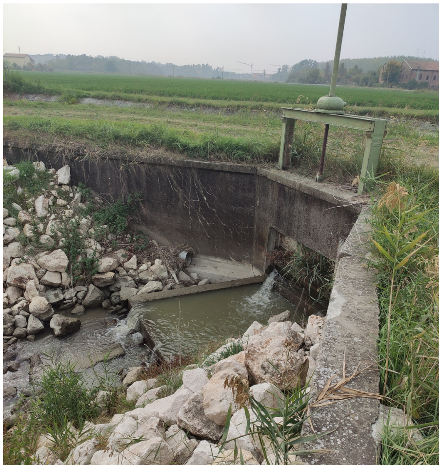
Figura 2.24: Vista di valle della botte-chiavica che permette al canale Quarantoli di sottopassare il canale Gavello.
