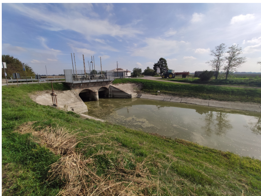
Figura 2.25: Vista di monte del sostegno Passo dei Rossi.
