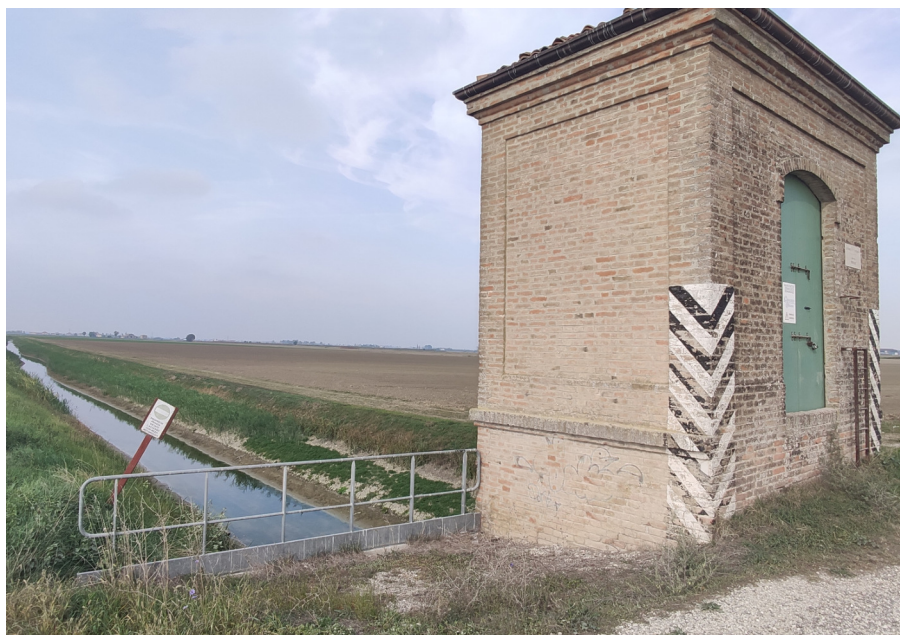
Figura 2.16: Vista dell'ultimo tratto della fossetta Forcole, appena a monte della chiavica che ne governa l'immissione nel canale Quarantoli. ben visibile la struttura in muratura che protegge gli organi meccanici della chiavica.
