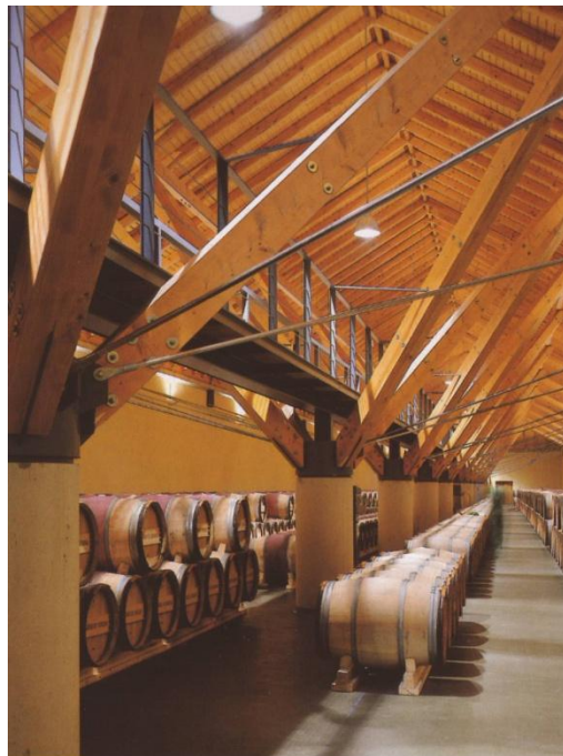
Viste della passerella centrale che attraversa la barricaia.
