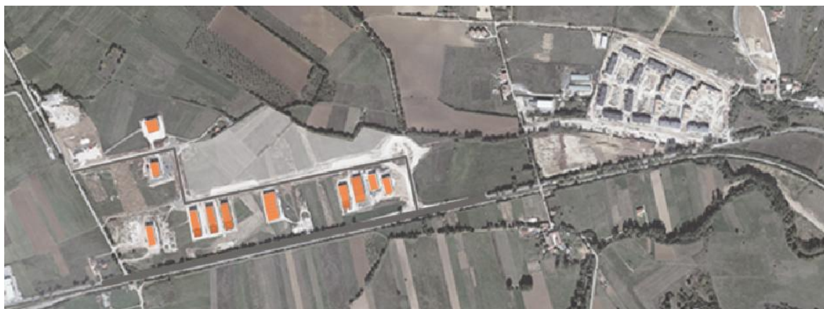
L'area di intervento e gli edifici industriali esistenti.
