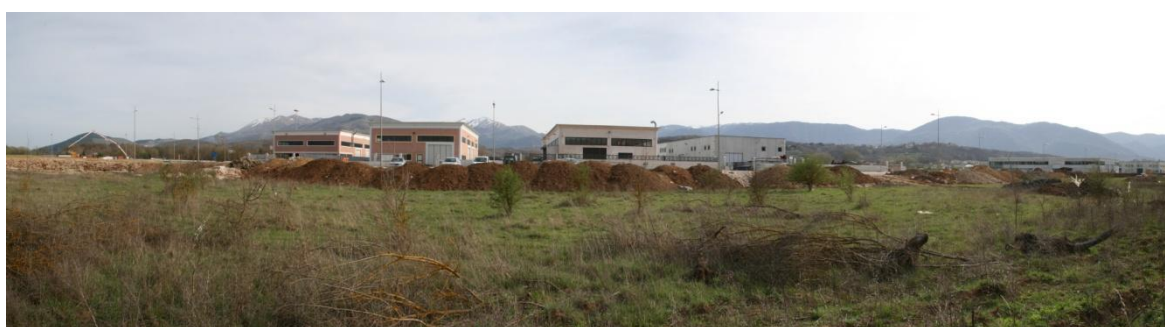
I confini: il fronte con gli edifici industriali costruiti.
