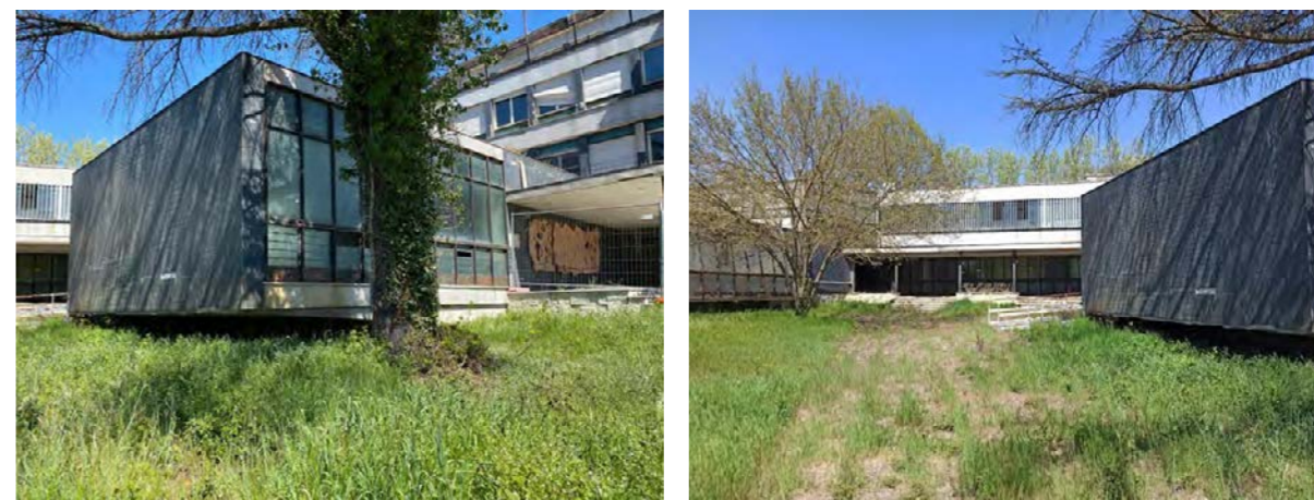
Figura 5 e 6: Edificio AU Rilievo fotografico realizzato dagli autori
