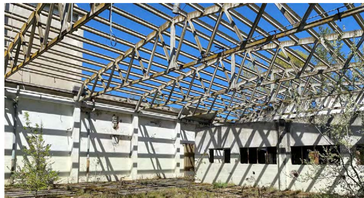
Figura 17: Edificio 25 Rilievo fotografico realizzato dagli autori
