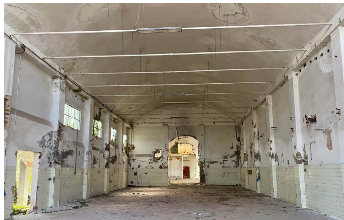
Figura 2, 3 e 4: Edificio A Rilievo fotografico realizzato dagli autori
