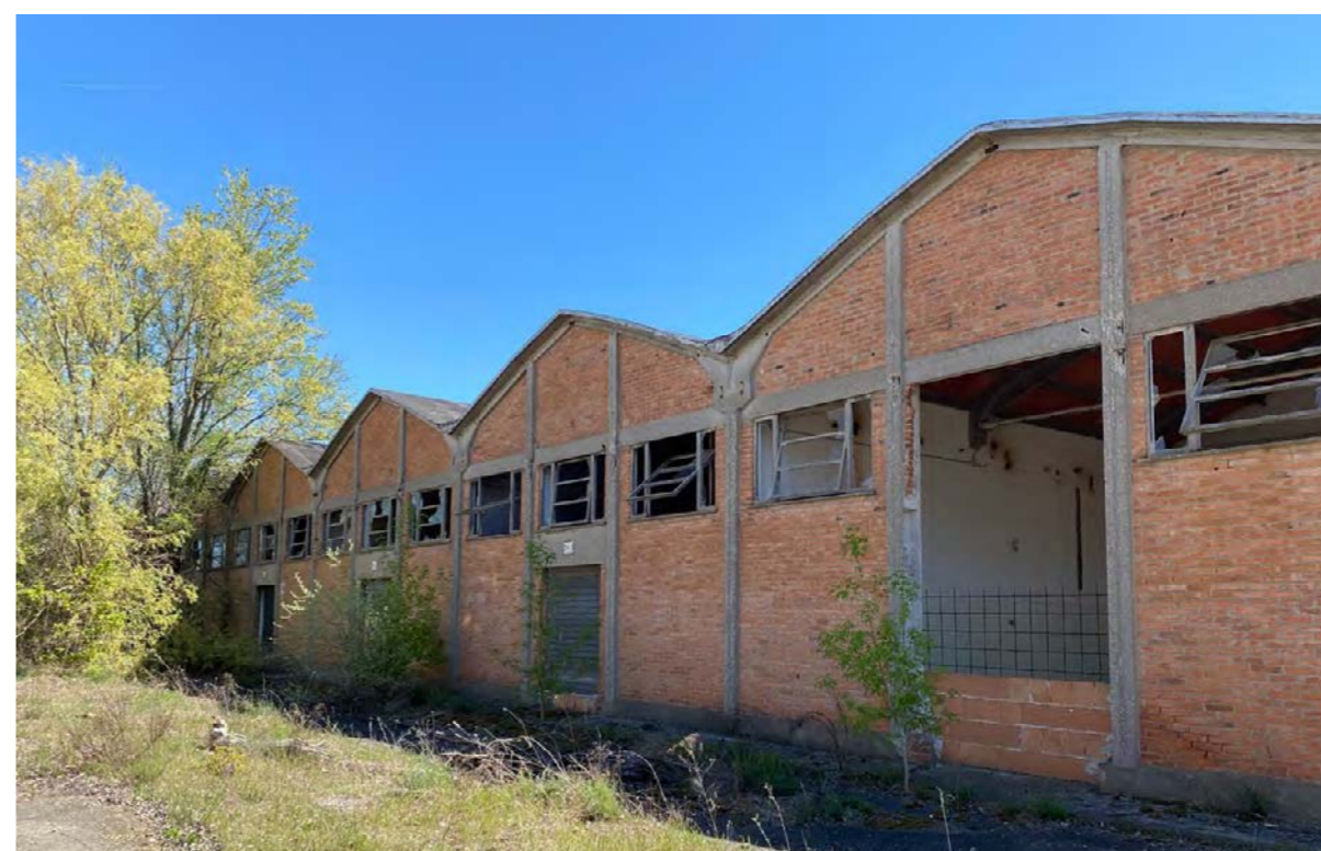
Figura 14, 15 e 16: Edificio G Rilievo fotografico realizzato dagli autori
