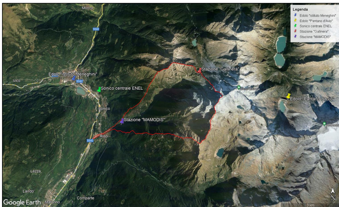
Figura 95: Ubicazione delle varie stazioni meteorologiche da cui sono stati prelevati i dati relativi alle colate passate rispetto al bacino del Rabbia.
