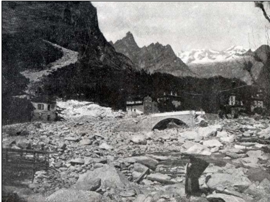
Figura 25: Colata detritica che travolge un’arcata del ponte della Strada Ardenno-Bagni di Masino (SO) nella notte fra il 21 e il 22 agosto 1911 (da Valentini, 1930)
