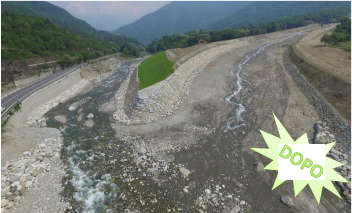
Figura 5: aspetto confluenza tra il torrente Rabbia e il fiume Oglio nel 2016, dopo la realizzazione di opere e interventi di mitigazione del rischio realizzati a seguito della significativa colata del luglio 2012 (da Pasquini, 2018).
