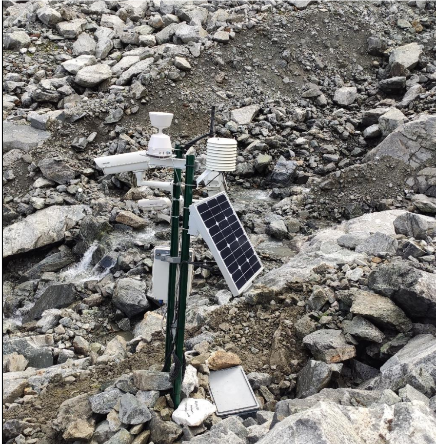
Figura 18: stazione di monitoraggio dotata di telecamere, pluviometro a bascula, sensore di temperatura, alimentazione a batteria esterna e solare.
