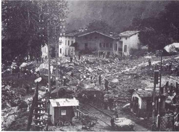
Figura 24. Fotografia storica scattata da Giacon Motta. Mostra la frazione di Campo investita dalla colata detritica, coinvolgendo abitazioni, la strada nazionale e la linea ferroviaria ( Rappelli, 2008 ).
