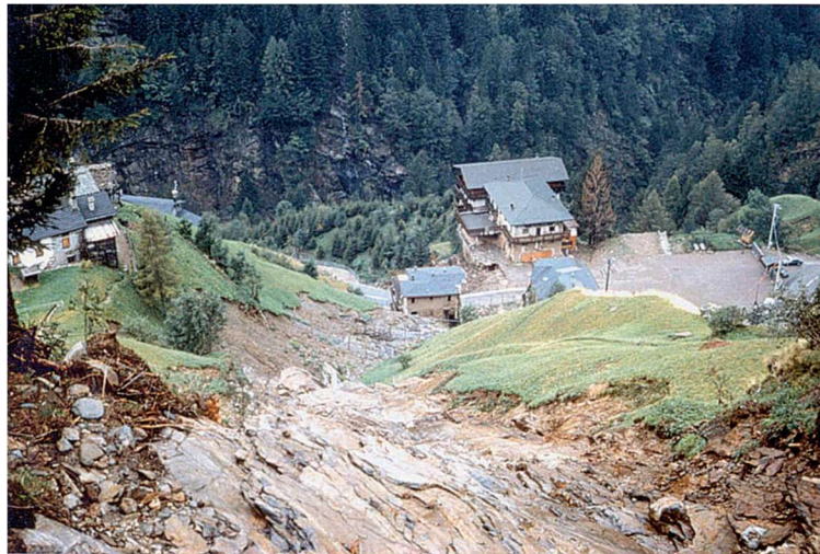
Figura 25. Panoramica della nicchia di distacco e di transito della colata. Sul fondo alcuni edifici coinvolti ( Regione Lombardia, 2000 ).
