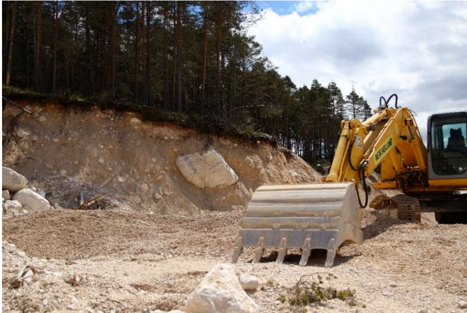
Figura 6. Zona di accumulo, rimaneggiata da mezzi meccanici, mostra la non-selezione verticale della granulometria. Foto scattata presso il debris-flow di Acquabona, Cortina d'Ampezzo (BL).
