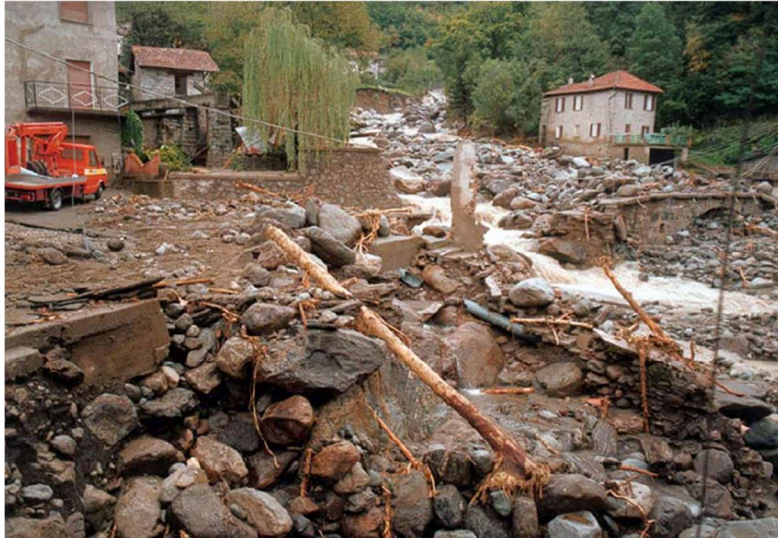
Figura 26. Immagine dell'abitato di Rino coinvolto nella colata detritica. Si notano alcuni edifici ed il ponte danneggiati. Foto presa dall'Archivio IRPI-CNR Torino ( Rappelli, 2008 ).
