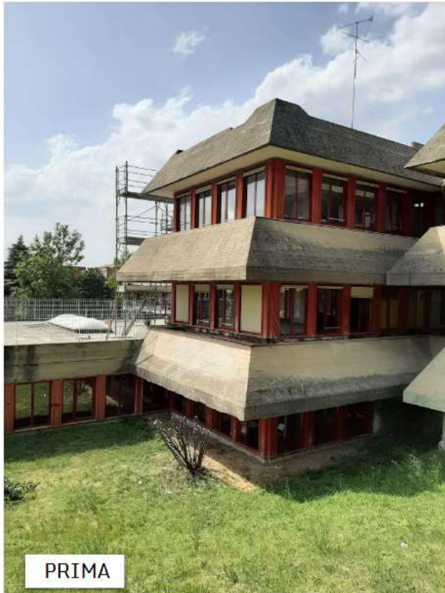
Figura 3.2 – Scuola media Galileo Galilei di Casalecchio di Reno – Riqualficazione delle facciate, impermeabilizzazione e coibentazione della copertura, immagine dell'edificio prima dell'intervento.
