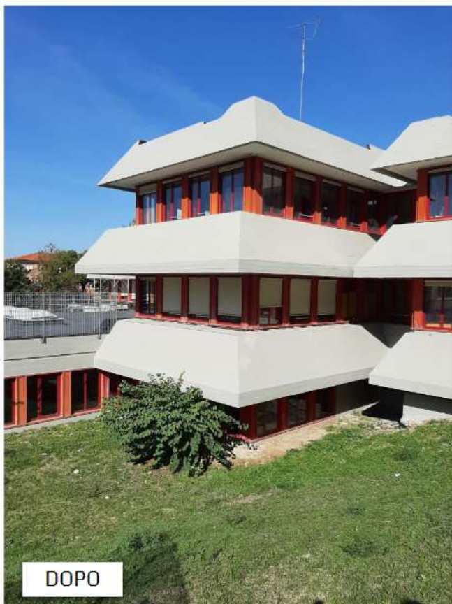
Figura 3.3 – Scuola media Galileo Galilei di Casalecchio di Reno – Riqualficazione delle facciate, impermeabilizzazione e coibentazione della copertura, immagine dell'edificio successiva all'intervento.
