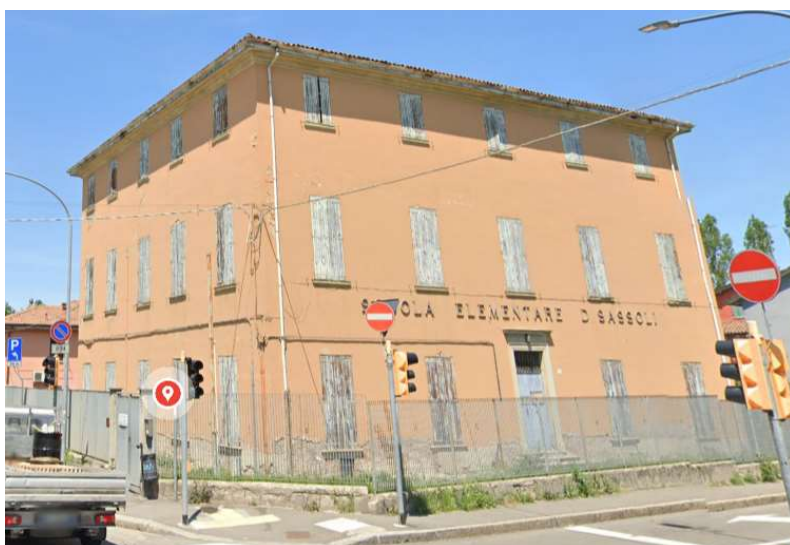
Figura 5.20– Ex scuola sita in via Zanardi 191, vista della facciata principale
