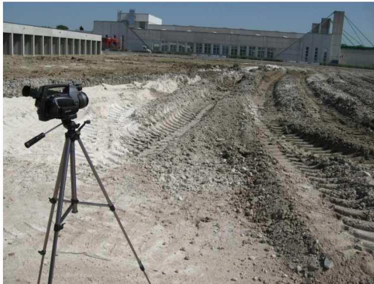
Fig. 5.21 – Situazione in essere del cantiere di Borgo Panigale.
