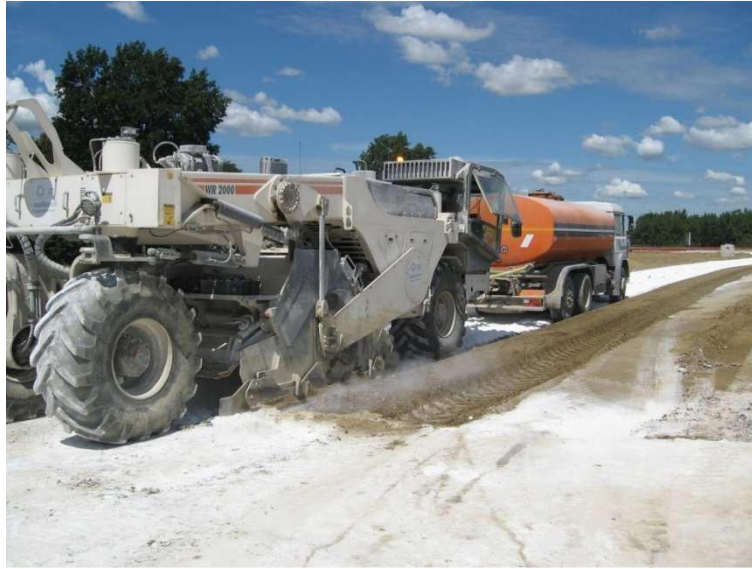
Fig. 5.25 – Operazioni di miscelazione nel cantiere di Granarolo dell’Emilia.
