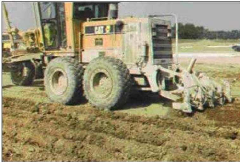
Fig. 4.4 – Scarificazione del terreno.
