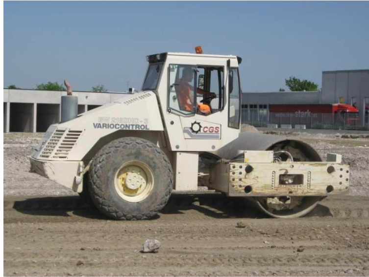
Fig. 4.18 – Compattazione con rullo Variocontrol di un terreno trattato a calce.
