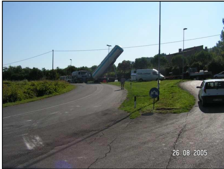
Fig. 4.2 – Automezzo per il trasporto e lo stoccaggio in sito della calce.
