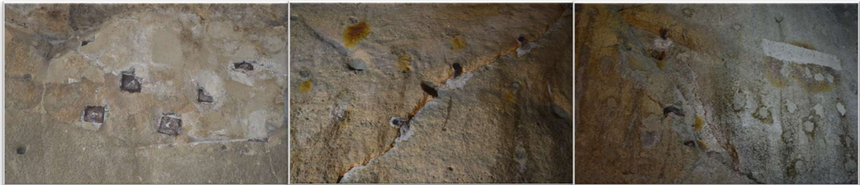
Figura 2.7: Barre passive installate nell'ammasso tufaceo con conseguente formazione di fratture
