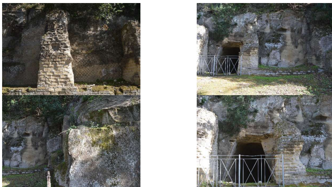
Figura 2.11: Stazione dalla quale si è eseguito il rilievo geomeccanico delle discontinuità
