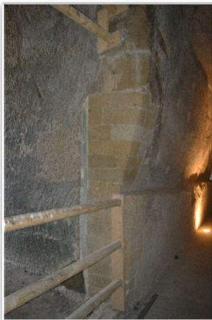
Figura 2.10: Muratura in tufo realizzata in sostegno a collassi localizzati
