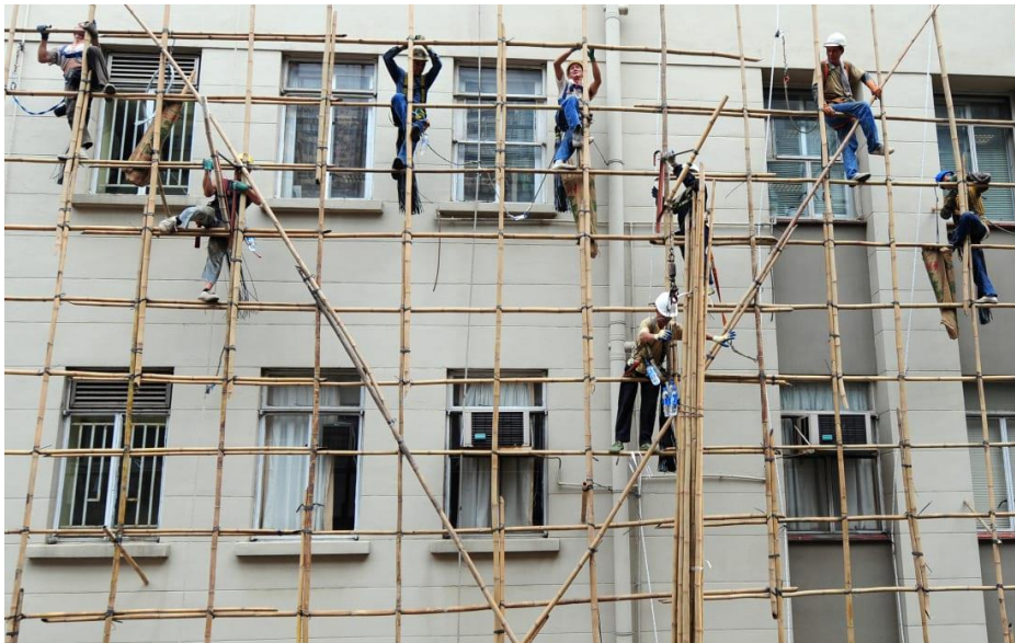
Figura 5: Esempio di impalcatura in bambù a Hong Kong 5
