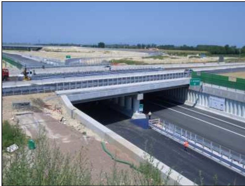
Fig. 17 - Esempio di opera completata: Passante autostradale di Mestre
