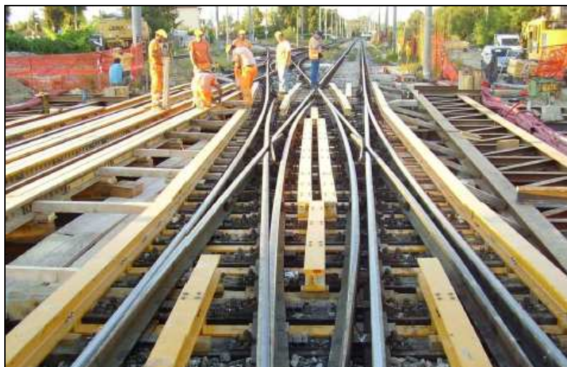
Fig. 33 – Ponte Essen in presenza di Deviatoi
