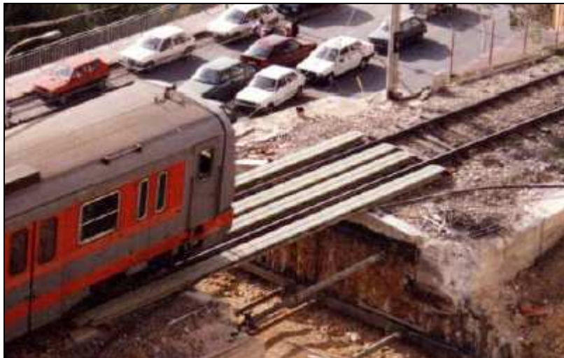
Fig. 34 – Ponte Essen in presenza di manufatti esistenti
