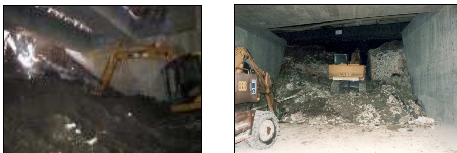
Fig. 4 - Terreno che viene accumulato e asportato dall'interno del monolite
