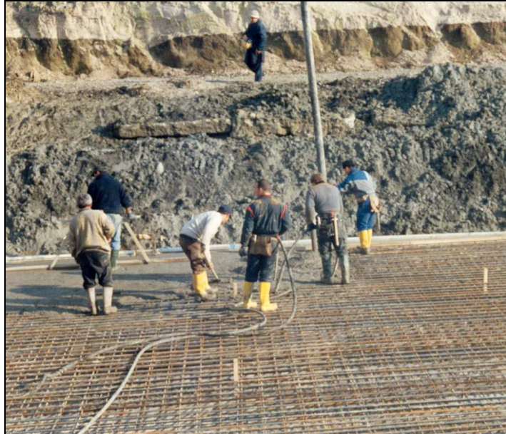
Fig. 6 - Realizzazione platea di varo
