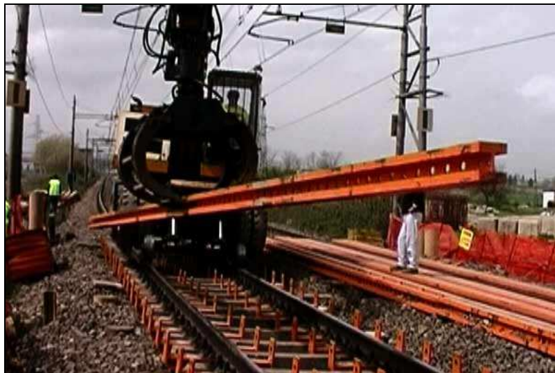
Fig. 26 - Posa in opera del “ponte Essen”
