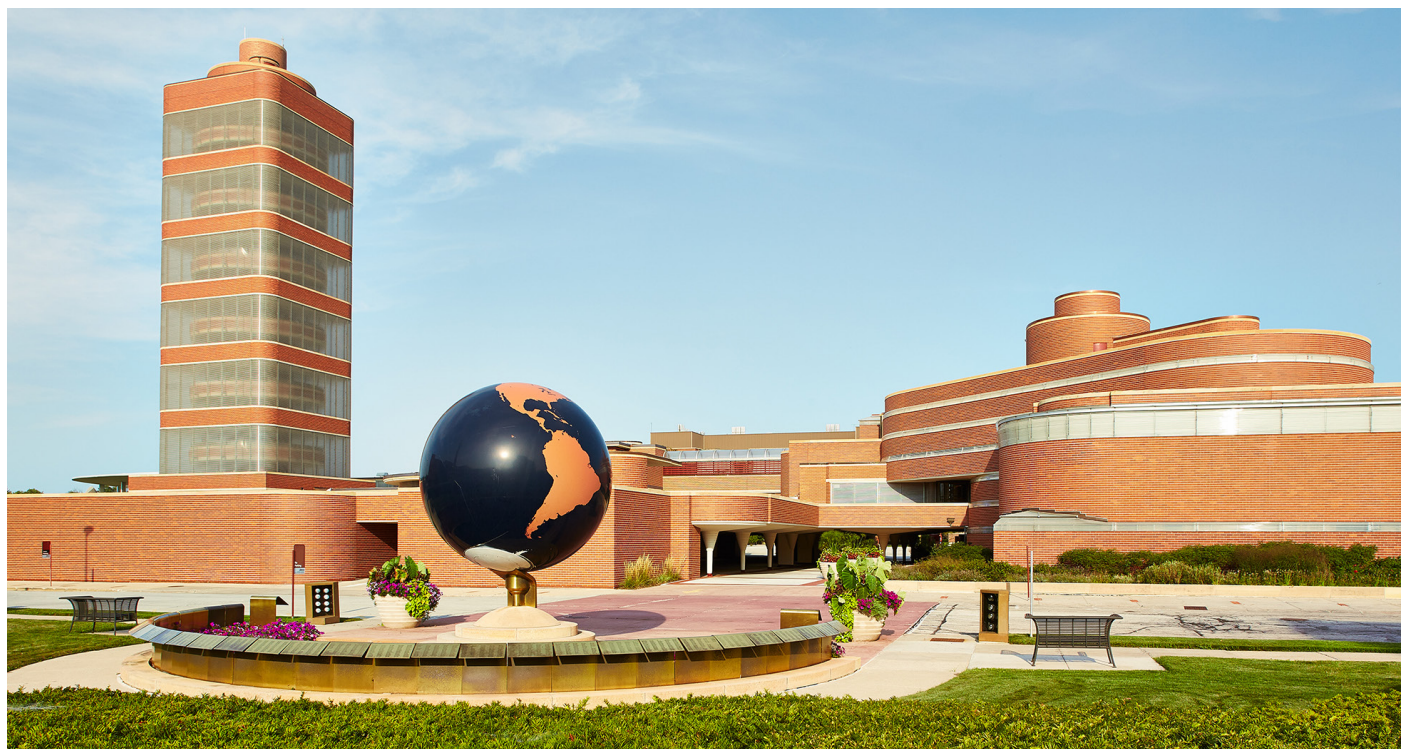
Figura 1.4 L'edificio degli uffici amministrativi e la torre delle ricerche della S.C. Johnson, progettati da Frank Lloyd Wright.
