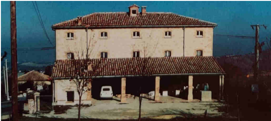
Fig. 56 - I9 Post restauro (Fonte: L. M. Morganti, "L'architettura. Le case rurali", p.1037 )
