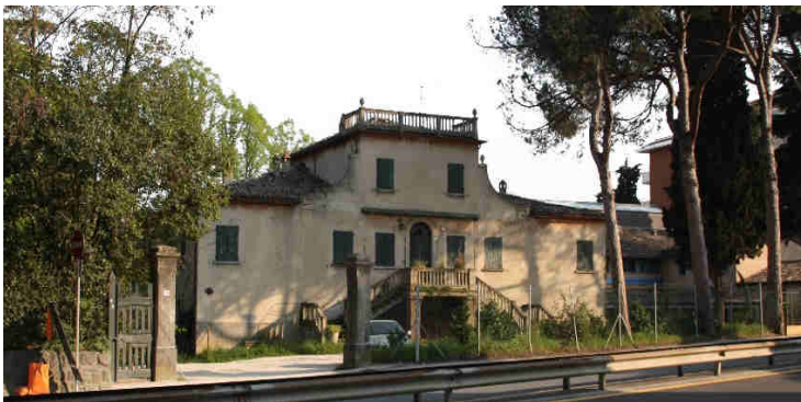
Fig. 12 – L’edificio prima del restauro
