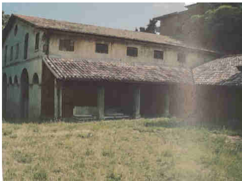
Fig. 13 – Esterno delle scuderie pre intervento (Fonte: R. Morri, "La Dogana", p.90)
