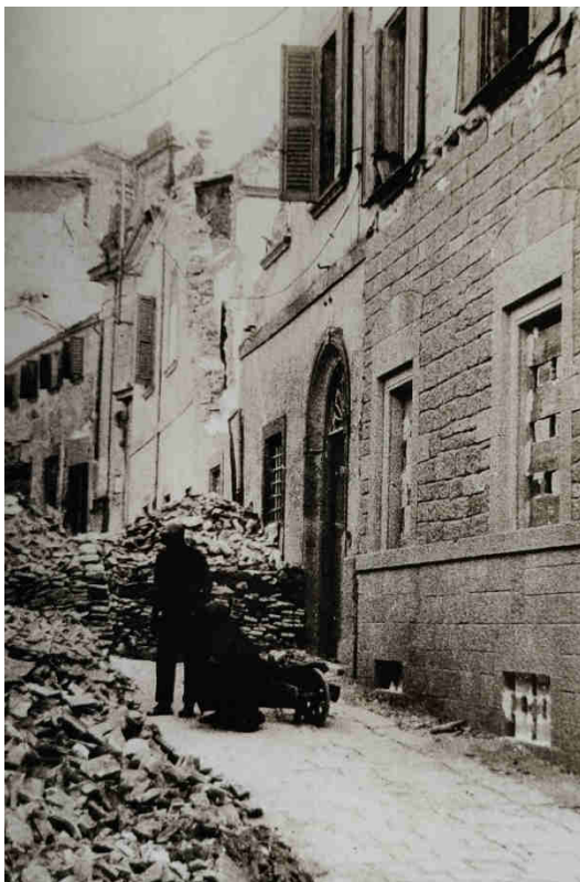
Fig. 123 – Palazzo Valloni dopo il bombardamento 1944 (Fonte: “Valloni. Storia di un palazzo”, p.41)
