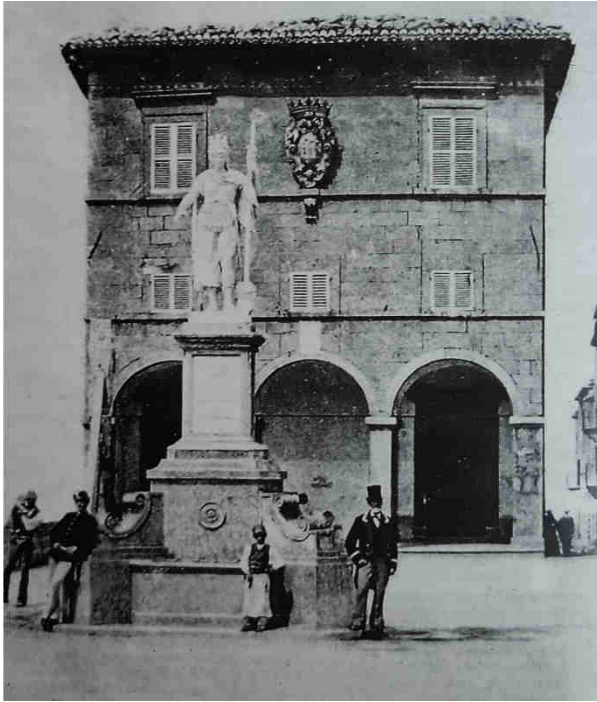
Fig. 126 – Palazzo Pubblico prima dell'intervento dell'Azzurri (Fonte: G. Zucconi, "Un palazzo medioevale dell'Ottocento")
