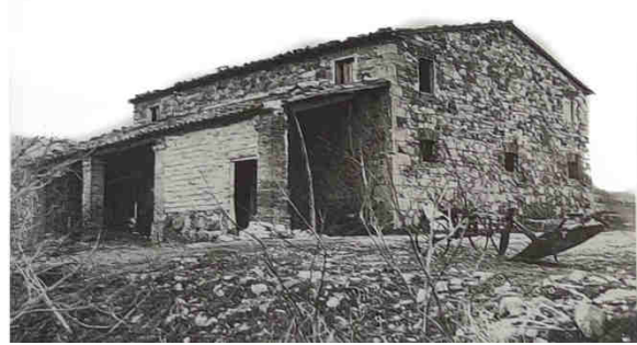
Fig. 59 – N12 prima del crollo (Fonte: L. M. Morganti, “L’architettura. Le case rurali”, p.1039)
