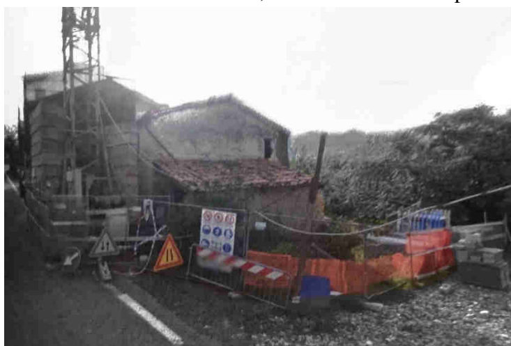
Fig. 45 – Chiesa di Corianino durante i lavori, 2010 (Fonte: Google Maps)
