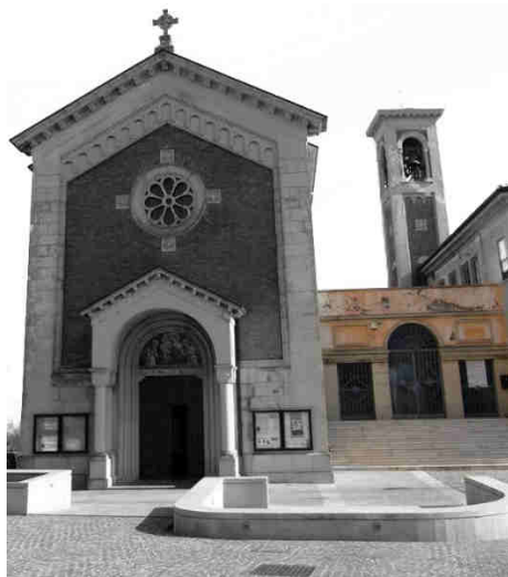
Fig. 31 – Canonica prima della demolizione (Fonte: http://www.diocesi-sanmarino-montefeltro.it/portfolio/parrocchia-di-san-michele-arcangelo-in-domagnano/ )
