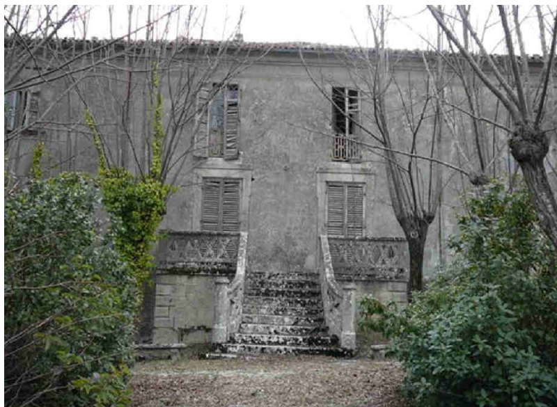
Fig. 54 – Villa Filippi-Balestra nel primo decennio del 2000 (Fonte: sito ama_rch , Riqualification and enlargement of ex Villa Filippi, Montegiardino RSM ) 2009)
