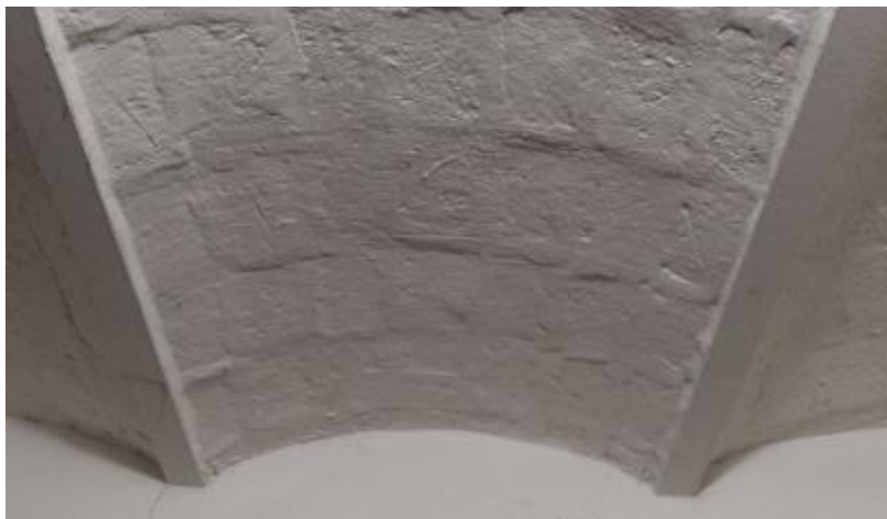
Figura 2.7: Intradosso del solaio in putrelle e voltine visibile dal piano seminterrato
