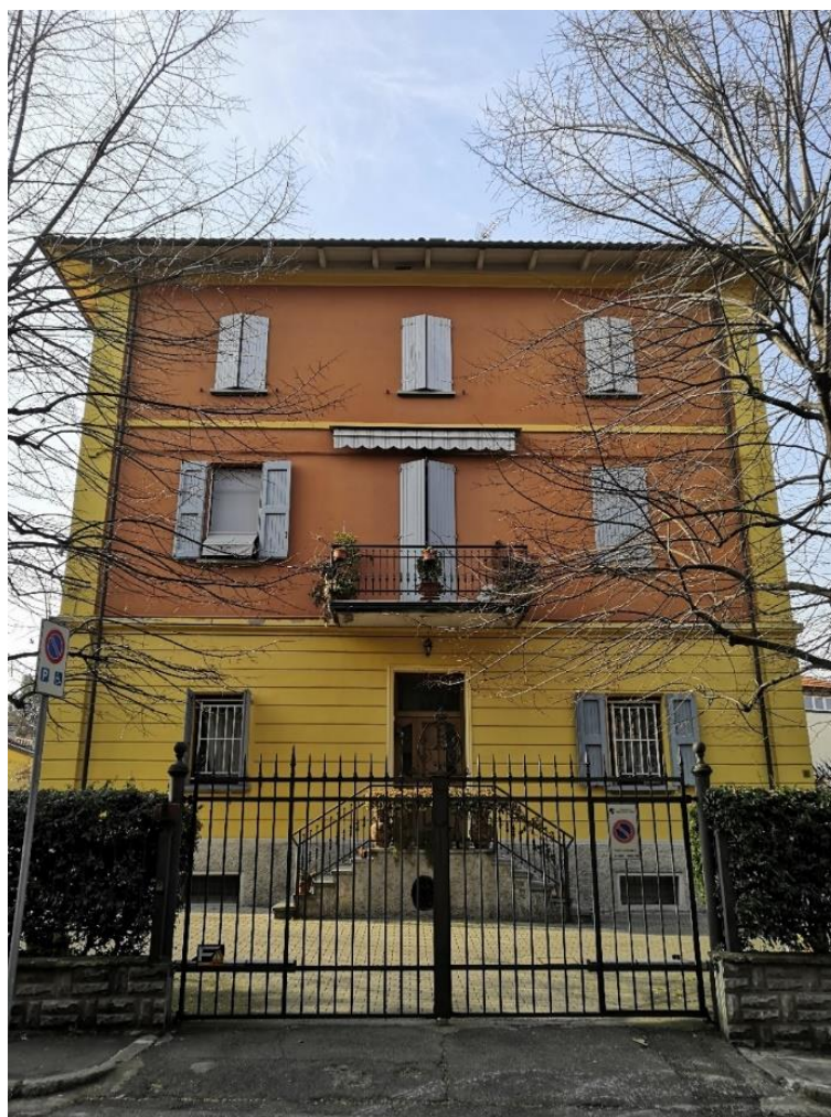
Figura 2.2: Vista lato Est con ingresso indipendente da via Tizzano
