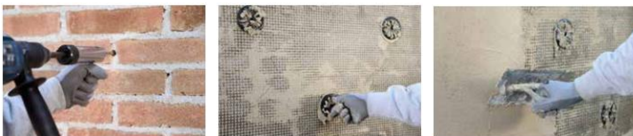
Figura 4.23: Installazione delle barre elicoidali; avvvitamento dei tasselli; applicazione seconda mano di malta [22]
