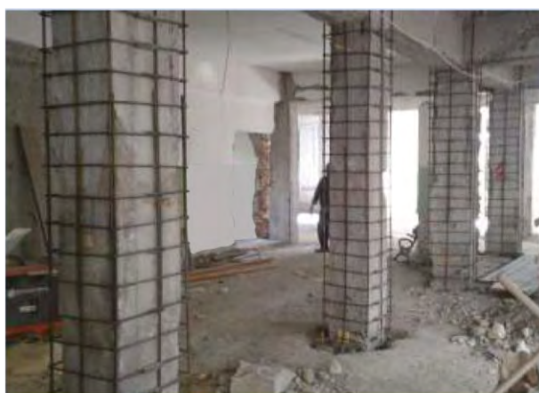
Fig. 48 Giacca in calcestruzzo applicata alle colonne
