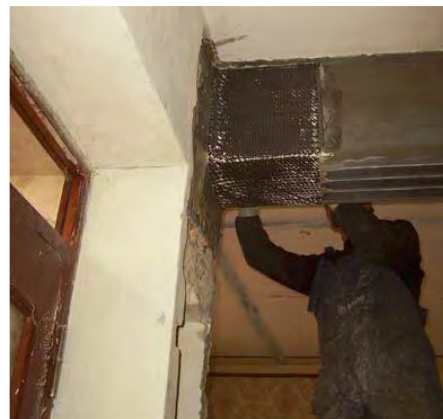
Fig. 23 Applicazione FRP ad una trave in CA
