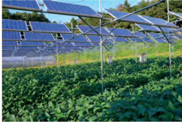
Figura 3.1: Esempio di impianto agrivoltaico con moduli elevati da terra
