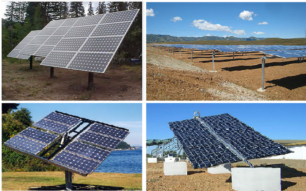
Figura 2.32: Inseguitori monoassiali di tilt, di rollio, di azimut e ad asse polare
