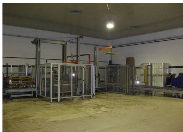
Figura 2.33 Pallettizzatore e avvolgipallet
