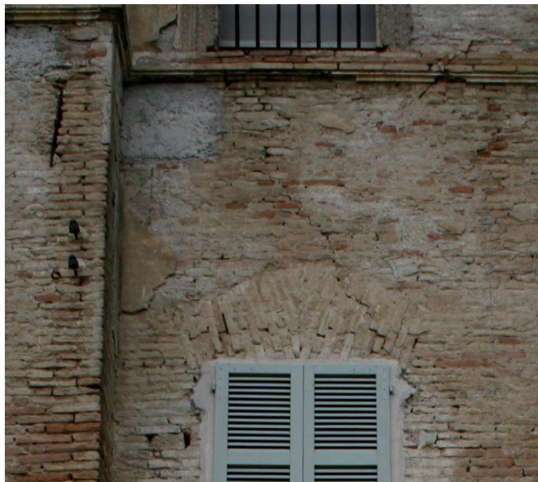
Fig. 56. Esempio di fessurazioni sopra la piattabanda. (FdA)
