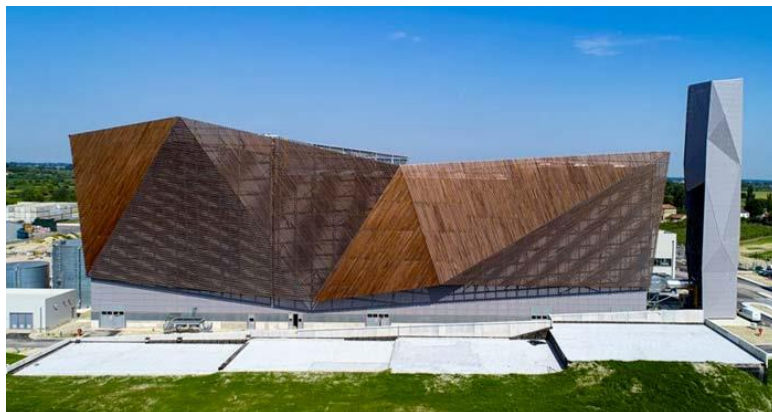
Fig. 33. La nuova centrale a biomasse PowerCrop.
