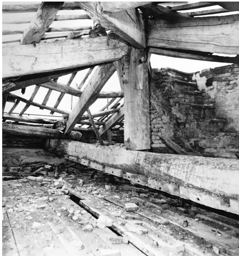
Fig. 41. L'orditura lignea del tetto.
