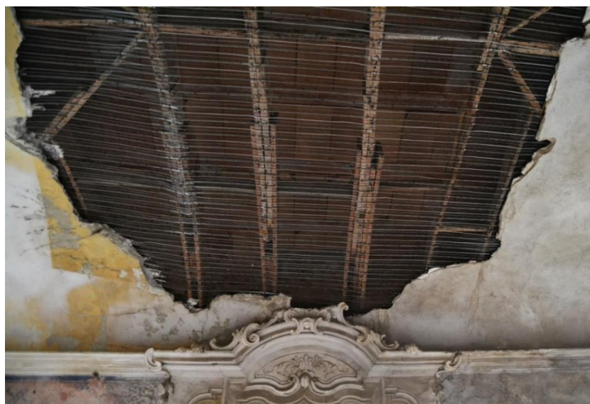
Fig. 39. La volta in canniccio. (FdA)
