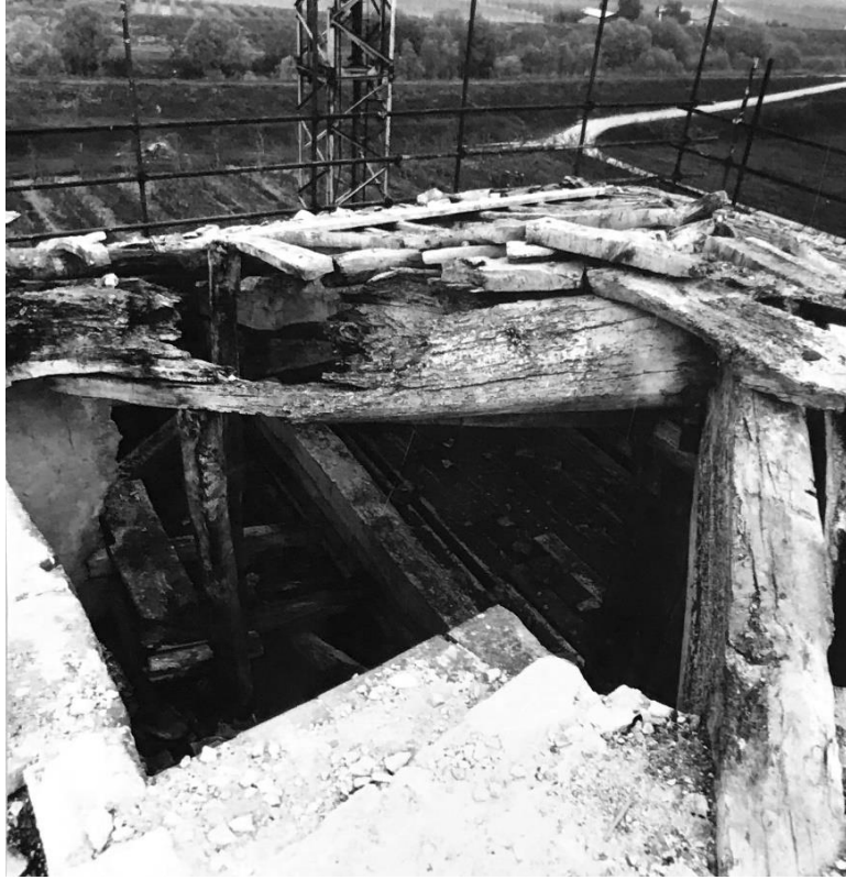
Fig. 40. Le capriate in legno della copertura.
