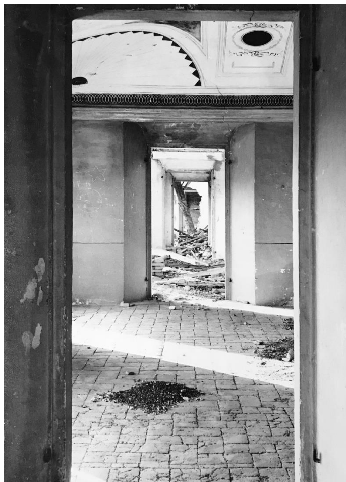
Fig. 44. La pavimentazione del secondo piano.
