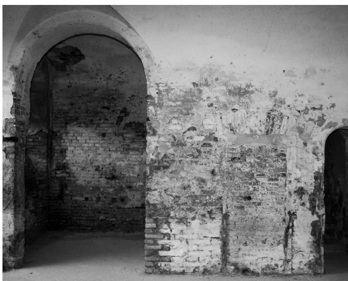
Fig. 36. Locale al piano terra. (FdA)
