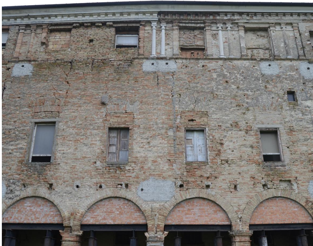
Fig. 58. Le lesioni del cantonale lato fiume. (FdA)
