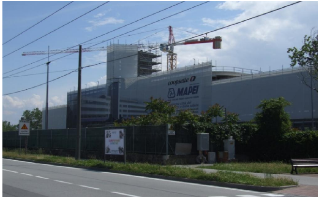
Colonia novarese allo stato attuale (sopra), e all'epoca della realizzazione (sotto)
