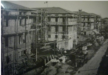
Cantiere della Colonia Bolognese in costruzione, fotografia dell'epoca
