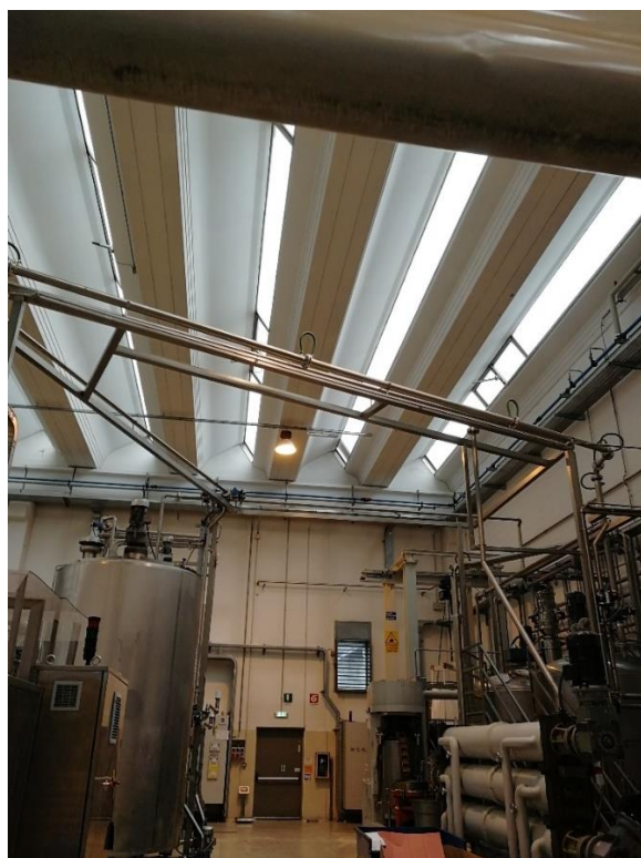
Fig.3,4,5 Particolari magazzino durante i rilievi iniziali
