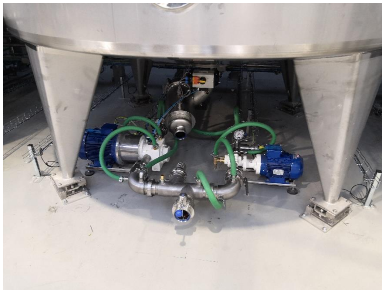
Fig.39 Particolare impianto sotto serbatoio da 50mc durante il montaggio in cantiere
