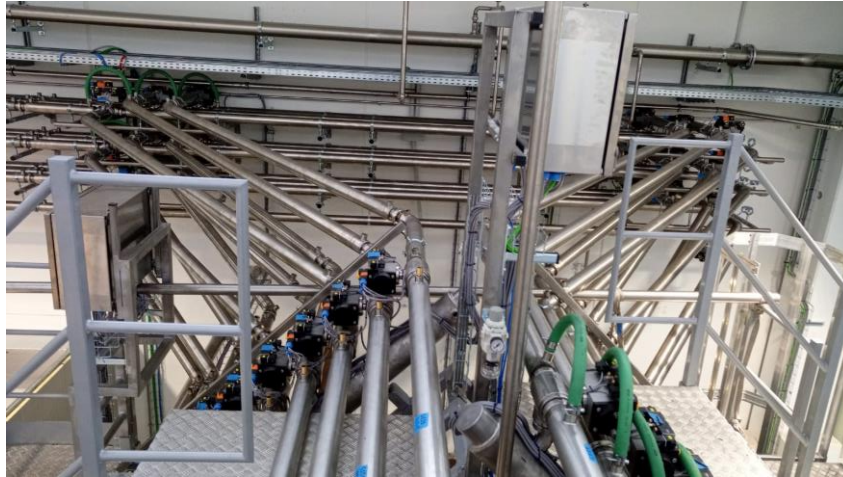
Fig.54 Valvole DN50 dopo posizionamento e montaggio in cantiere
