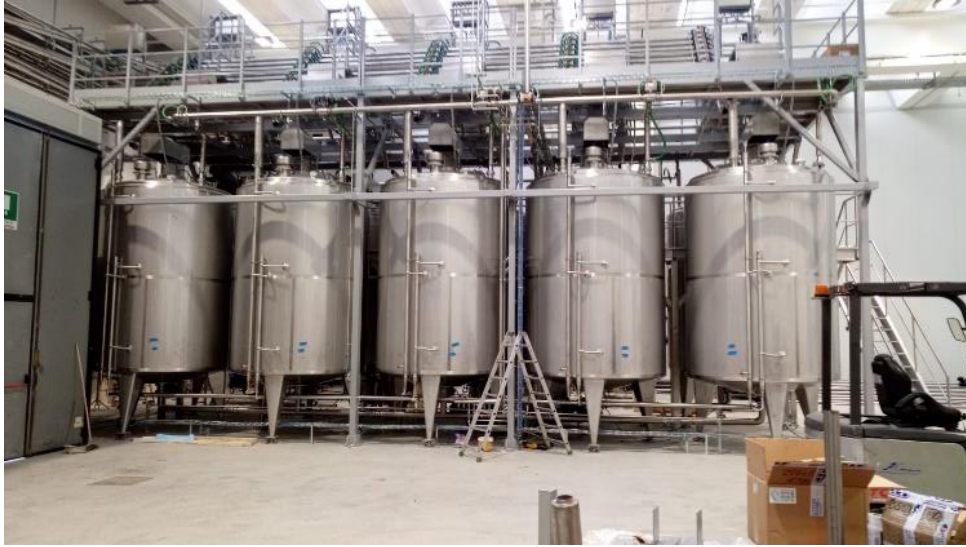
Fig.57 Particolare della zona stoccaggio creme bianche durante i lavori
