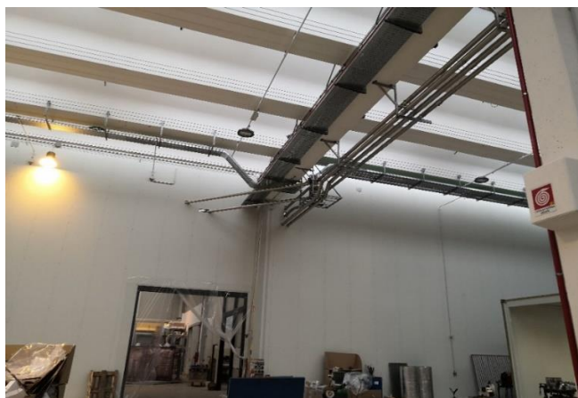
Fig.20 Realizzazione finale del sostegno delle tubazioni polveri
