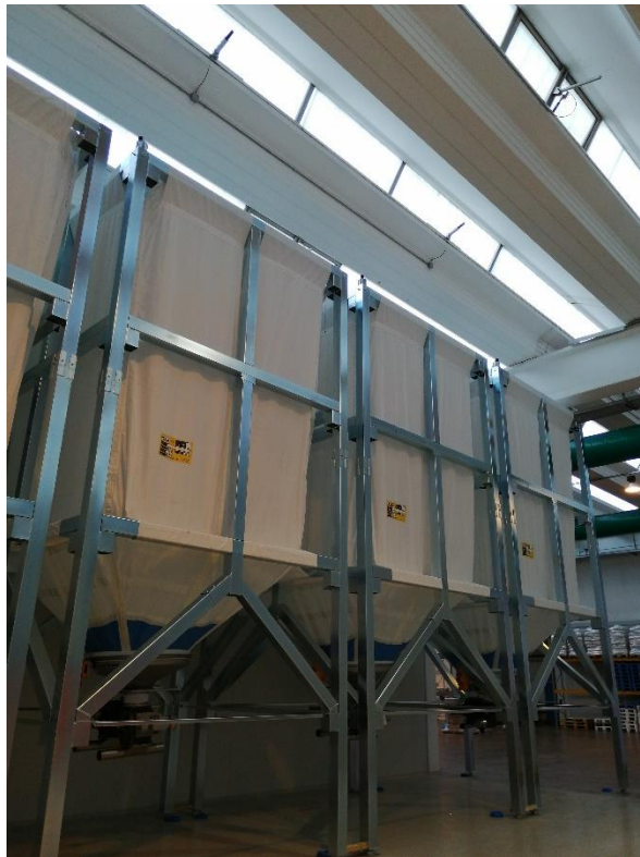
Fig.9 STX dopo posizionamento e montaggio in cantiere
