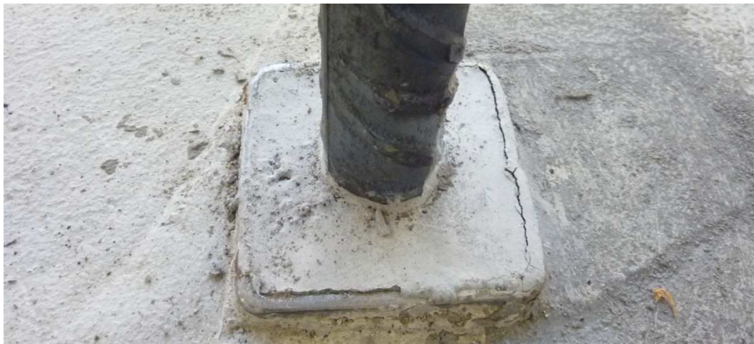
Figura 5.128 Fessure tra lo scatolare in acciaio e il getto di EMACO formatesi durante l'applicazione dei vari cicli di forza orizzontale.
