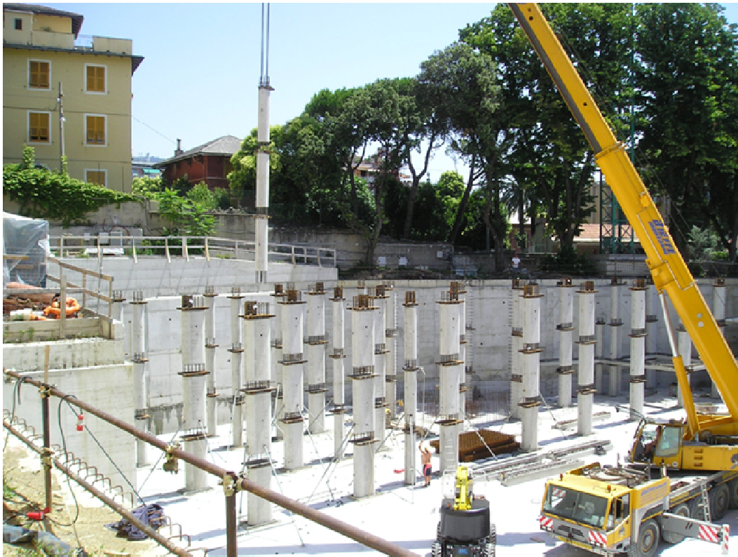
Figura 1.5 Edificio pluripiano realizzato con innesti a trespolo in sommità dei pilastri.
