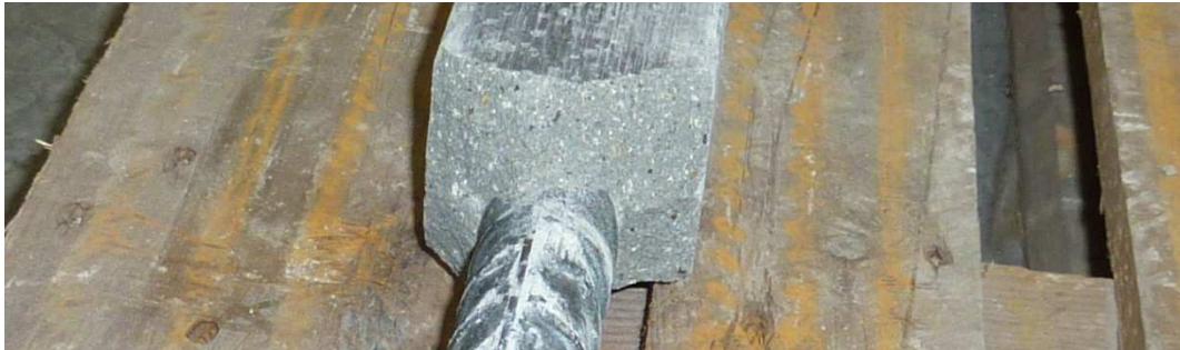
Figura 5.16 Particolare della superficie di rottura del getto di Emaco.
