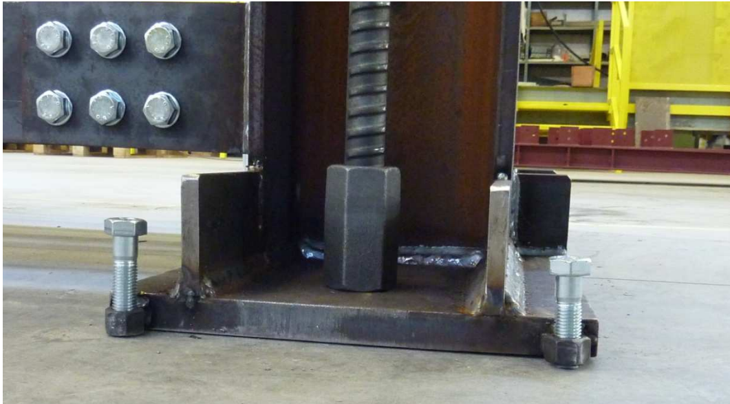
Figura 8.24 Particolare delle viti che vengono utilizzate per mettere in bolla il timpano di contrasto.
