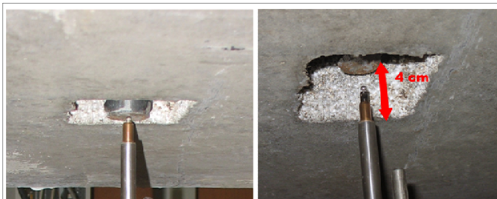
Figura 5.11 Intradosso del plinto prima e dopo la prova.
